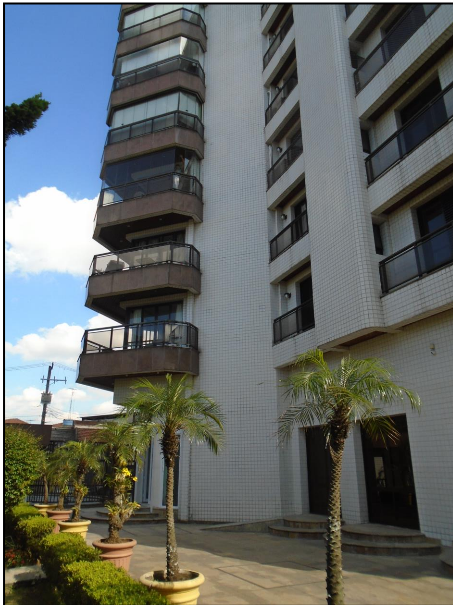
FOTO 25 – RECUO EXTERNO PARA ACESSO AO PAVIMENTO SUBSOLO.
