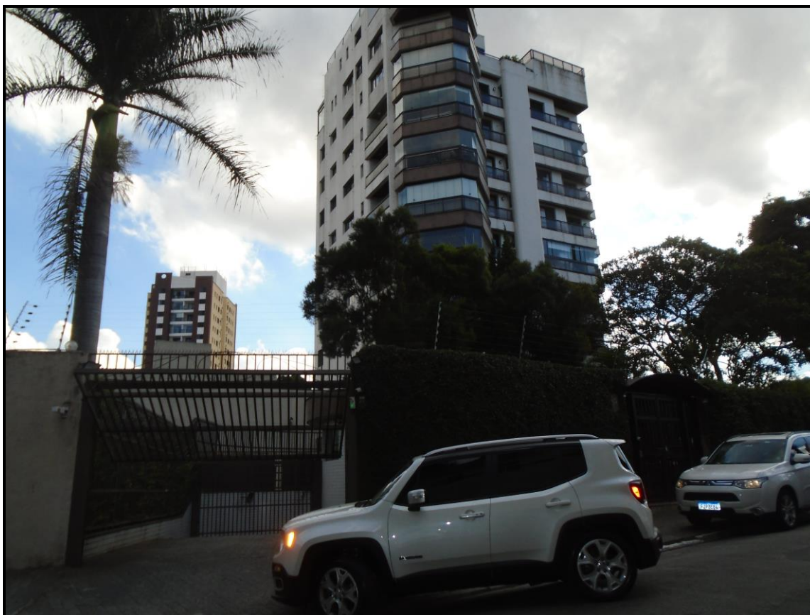
FOTO 18 – ENTRADA PARA PAVIMENTO SUBSOLO.
