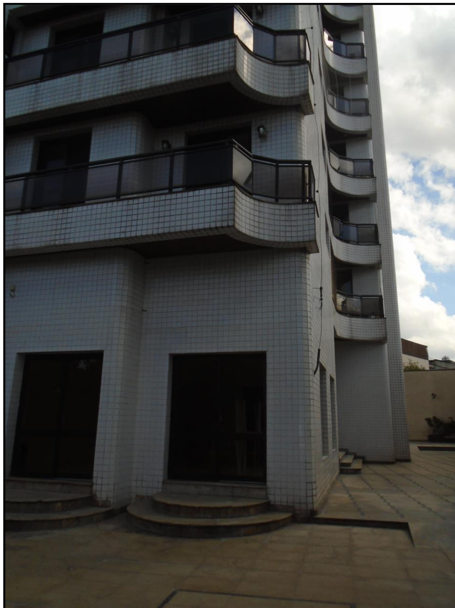
FOTO 17 – PORTAS PARA ACESSO ÀS AREAS LAZER.
