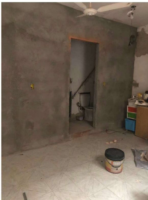
Foto 12: Sala em reforma
