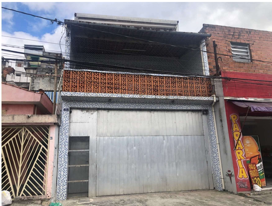
Foto 1: Rua Miguel Gomes, nº 75, Jardim Jaçanã, São Paulo - SP
