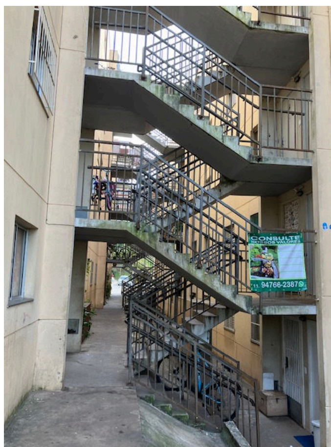
Figura 9- escadas de acesso aos apartamentos do Bloco 04
