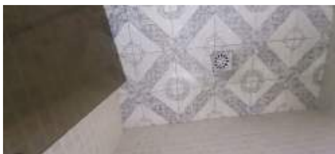
Piso no banheiro da Suíte 01
