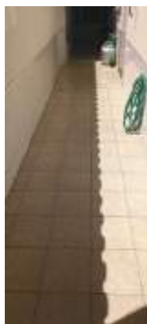
Piso do corredor externo (sacada)
