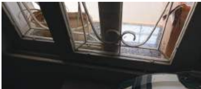
Janela da sala de jantar
