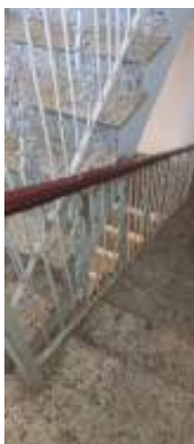
Corrimão das escadas
