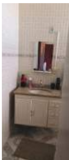
Lavatório do banheiro do quarto 04
