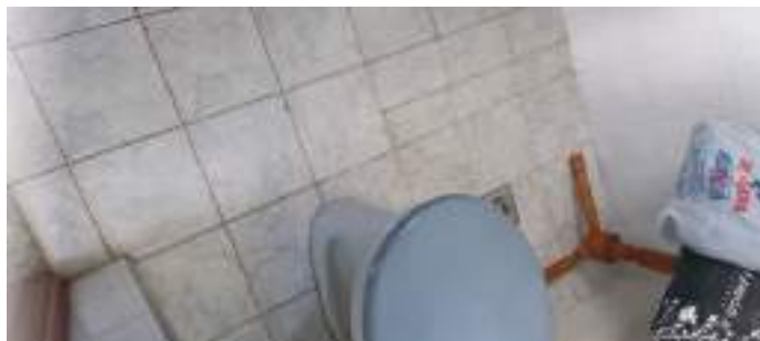
Piso do banheiro da área de serviço
