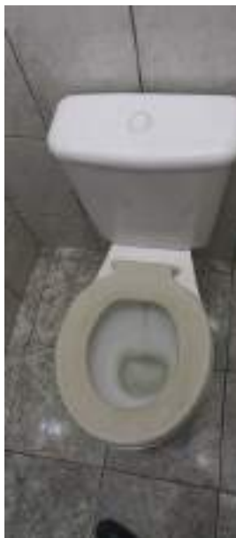
Vaso sanitário do banheiro masculino
