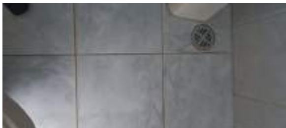
Piso do banheiro social
