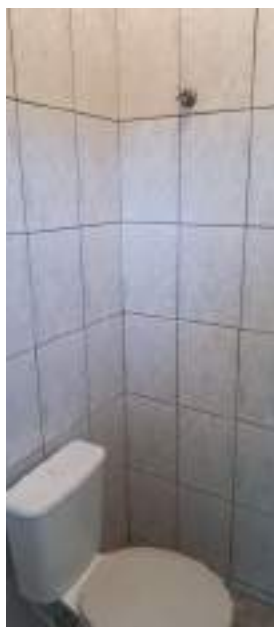
Azulejos e vaso sanitário do banheiro feminino
