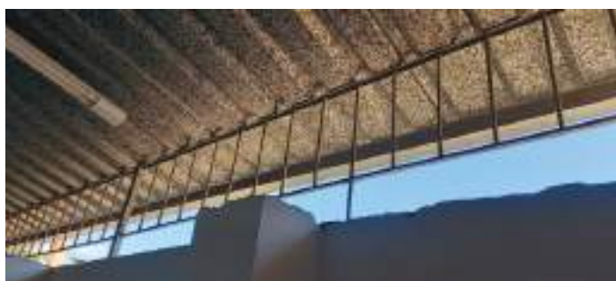
Cobertura da área de serviço
