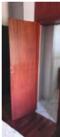
Acesso ao Banheiro do Quarto 03
