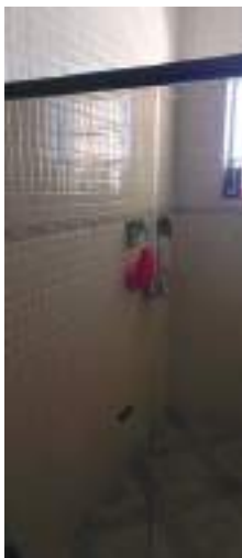
Box e paredes do banheiro do quarto 04
