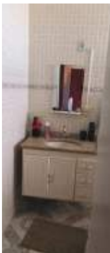
Lavatório do banheiro do quarto 04
