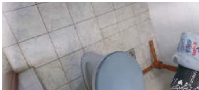
Piso do banheiro da área de serviço
