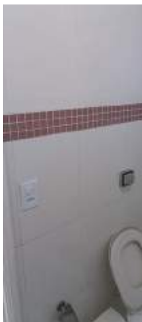
Paredes do banheiro privativo da sala do Gerente
