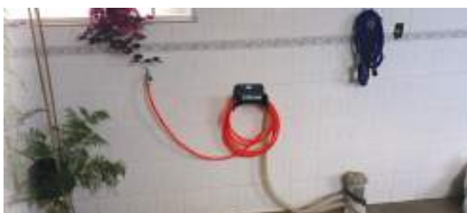
Paredes da área de serviço
