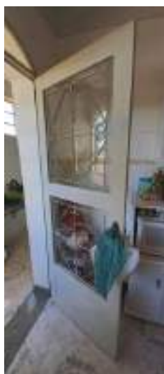
Porta para acesso ao corredor
