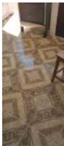
Piso da Cozinha
