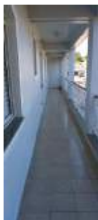
Piso do corredor externo (sacada)
