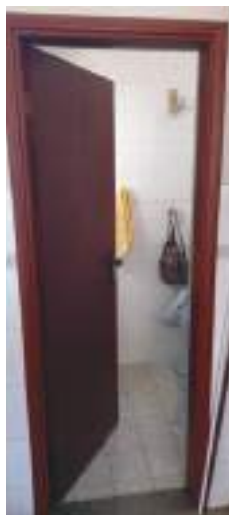
Banheiro da área de serviço
