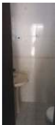
Banheiro da área de serviço
