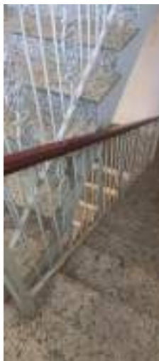
Corrimão das escadas
