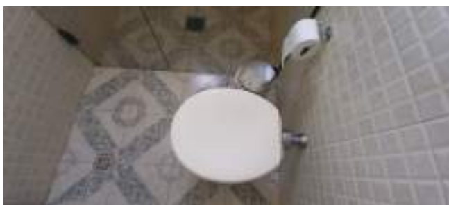
Piso e vaso sanitário do banheiro social
