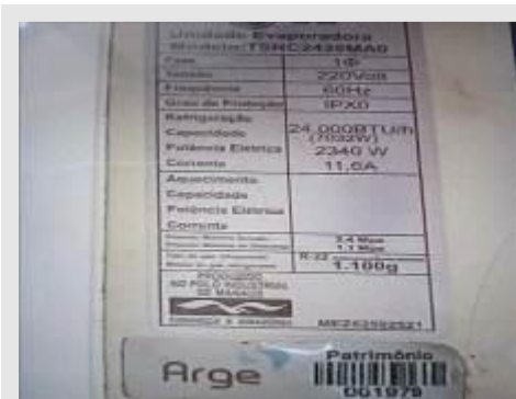
APARELHO CONDICIONADOR DE AR MARCA LG MOD TSNH2425MA0 POT 24000 BTU TENSÃO 220 V | Item: 777 |
