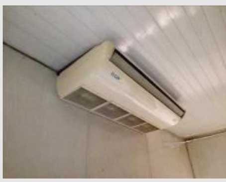
APARELHO CONDICIONADOR DE AR MARCA ELGIN MOD PHFI 60000 2 POT 60000 BTU TENSÃO 220 V | Item: 410 |
