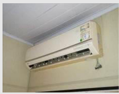
APARELHO CONDICIONADOR DE AR MARCA LG MOD TSNC092YMA1 POT 12000 BTU TENSÃO 220 V | Item: 375 |
