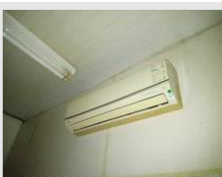
APARELHO CONDICIONADOR DE AR MARCA LG MOD TSNC092YMA1 POT 9000 BTU TENSÃO 220 V | Item: 290 |
