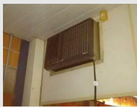
APARELHO CONDICIONADOR DE AR MARCA CONSUL MOD AIR MASTER POT 10000 BTU TENSÃO 220 V | Item: 291 |
