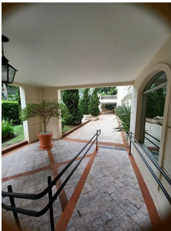
Foto 16: área externa ao hall social
