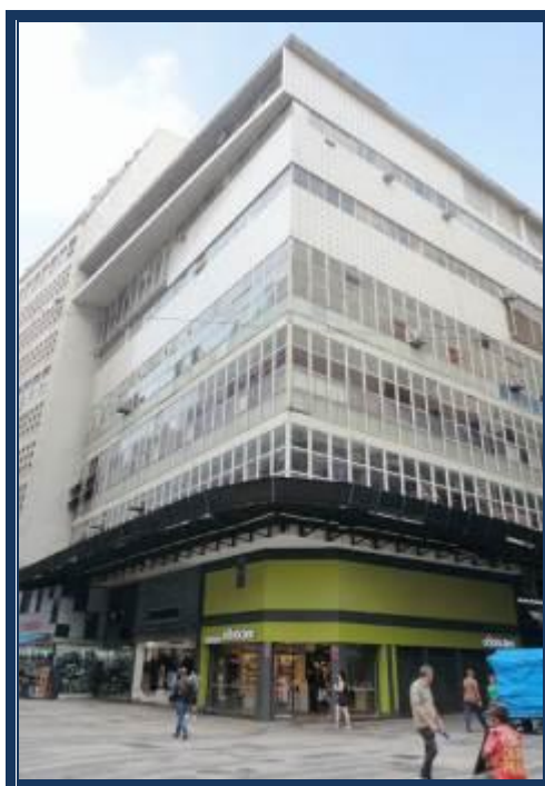
Vista geral do Edifício Louzã – Shopping Center Barão de Itapetininga.
