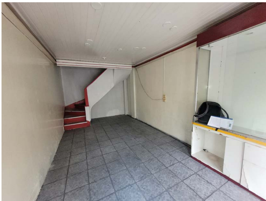
Fotografia 07 – Vista interna do pavimento térreo do imóvel avaliado (loja).
