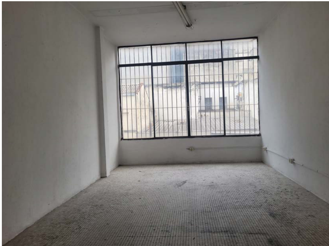
Fotografia 11 – Vista interna do 2º pavimento do imóvel avaliado.
