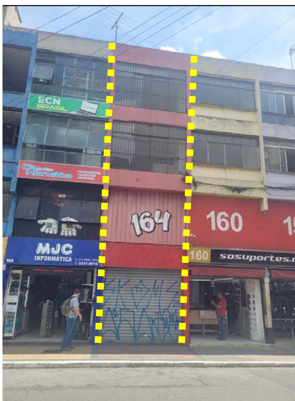
Fotografia 04 – Vista da frente do imóvel avaliado (limites tracejados em amarelo) junto ao alinhamento da Rua dos Timbiras.
