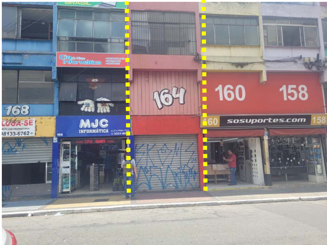
Fotografia 05 – Vista da frente do imóvel avaliado (limites tracejados em amarelo) junto ao alinhamento da Rua dos Timbiras.
