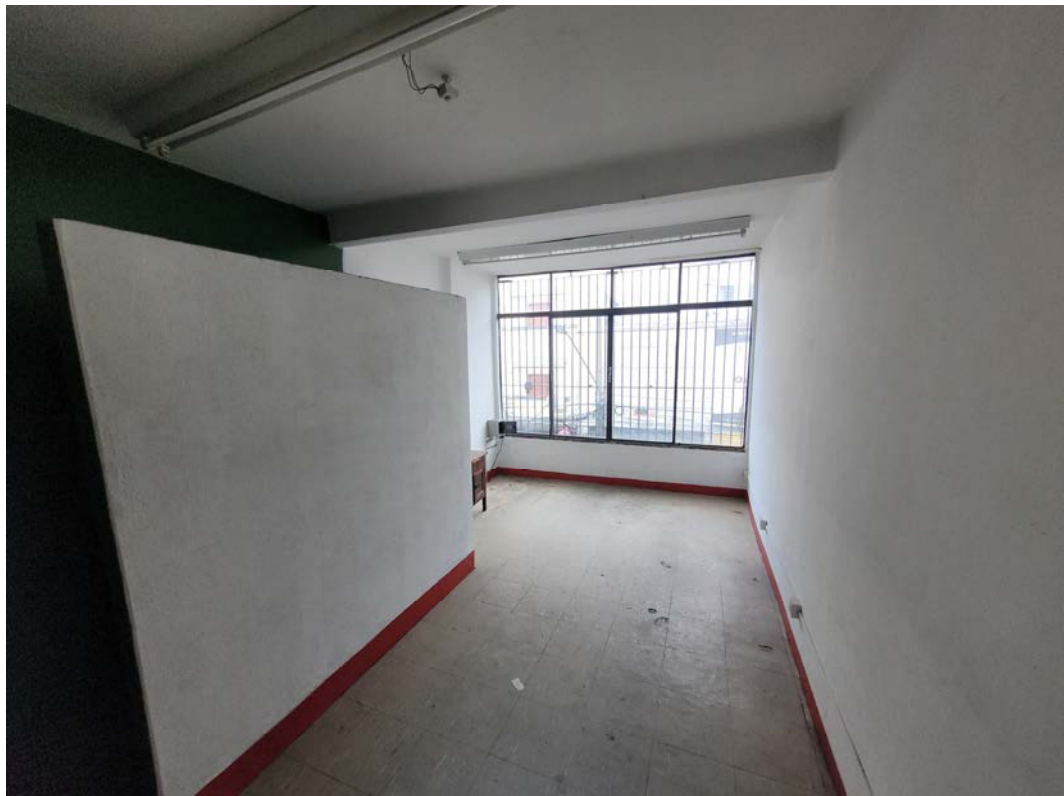
Fotografia 10 – Vista interna do 1º pavimento do imóvel avaliado.
