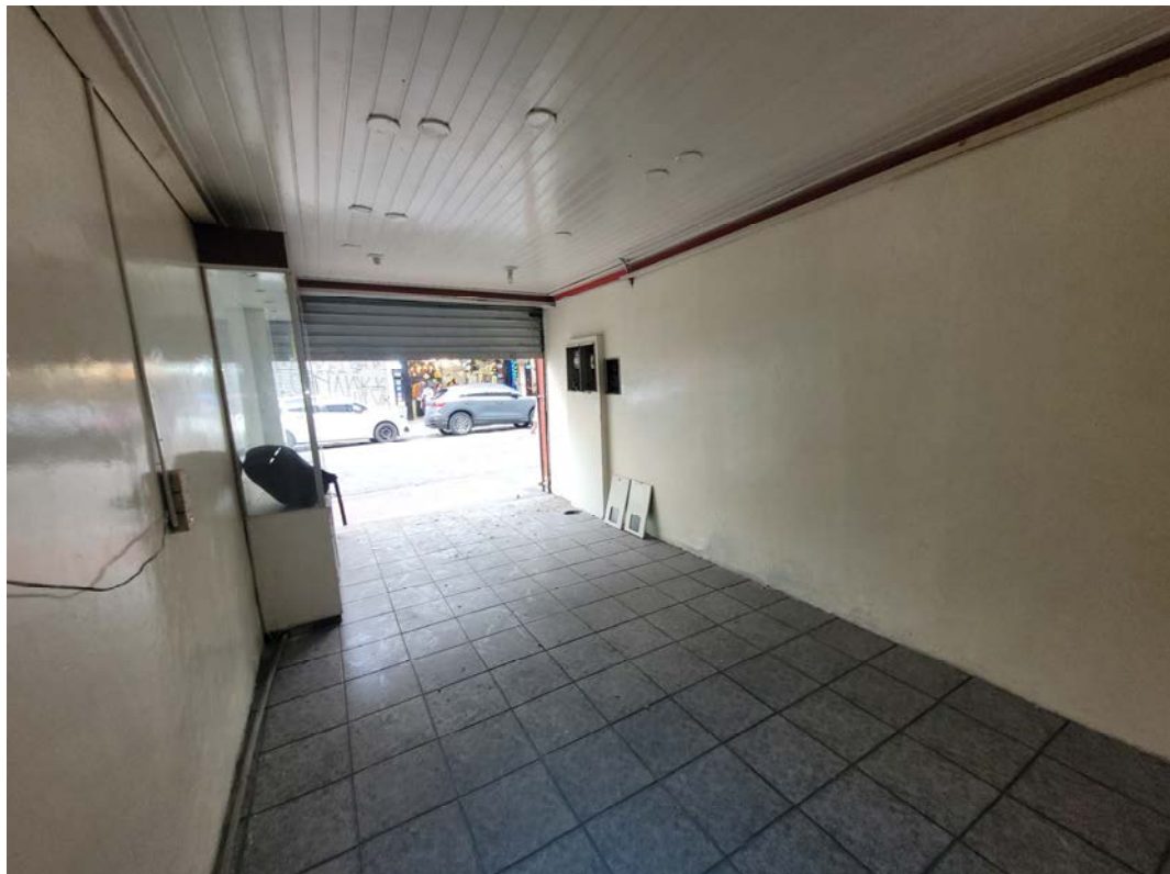
Fotografia 06 – Vista interna do pavimento térreo do imóvel avaliado (loja).
