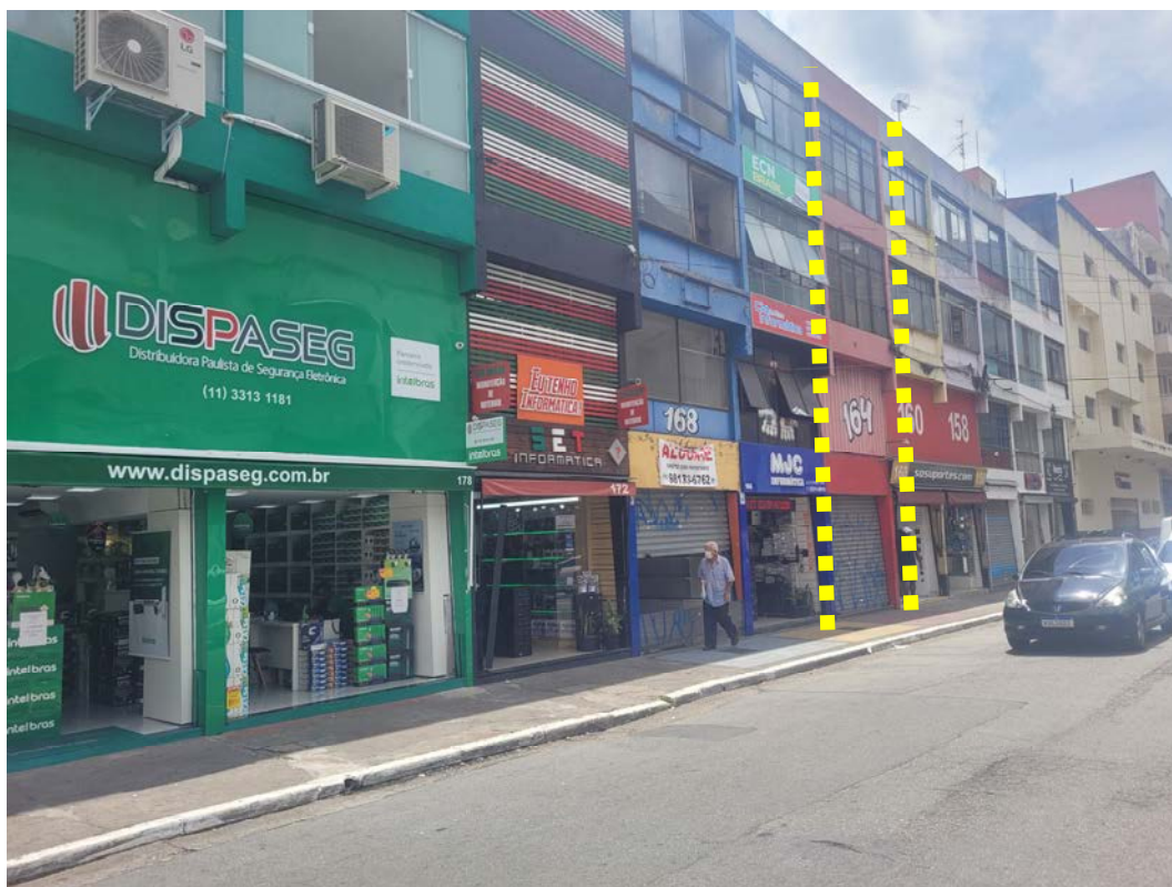
Fotografia 03 – Vista da frente do imóvel avaliado (limites tracejados em amarelo) junto ao alinhamento da Rua dos Timbiras.
