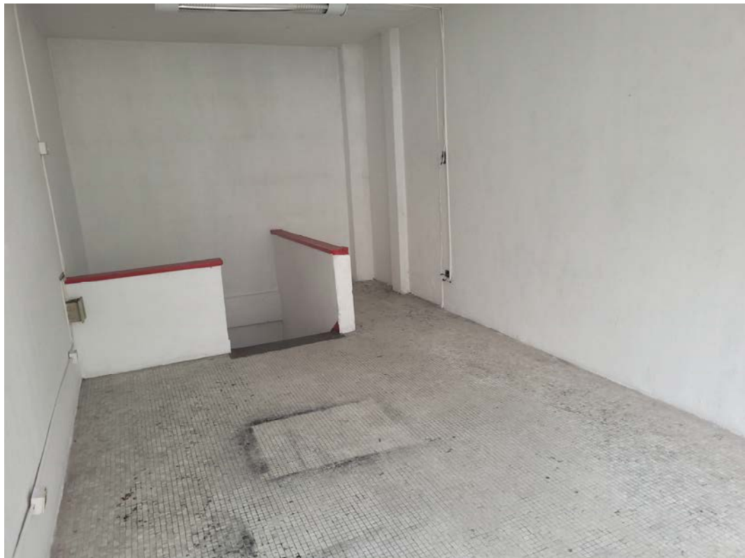
Fotografia 12 – Vista interna do 1º pavimento do imóvel avaliado.
