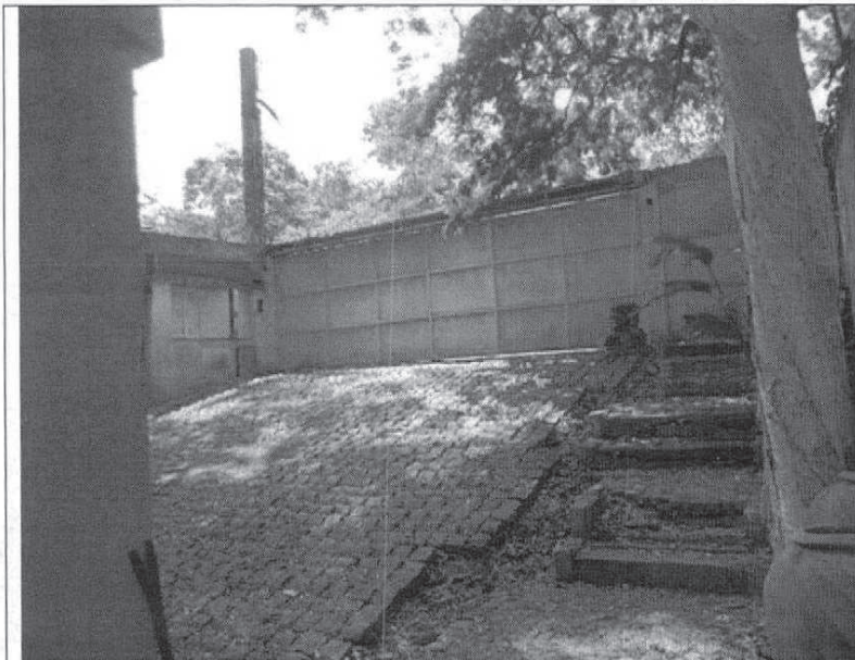
DESNÍVEL ENTRE A RUA ALABARDA E A FRENTE DA CONSTRUÇÃO.
