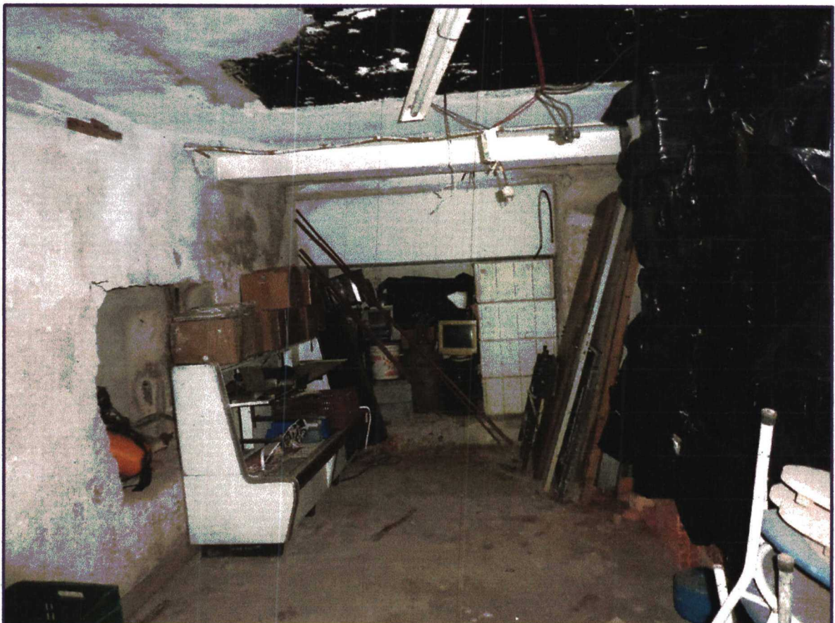
VISTA INTERNA DO DEPÓSITO.
