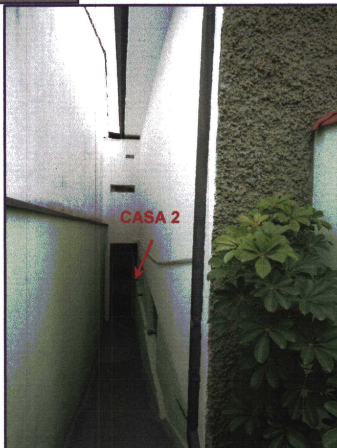
VISTA DA EDIFICAÇÃO: CASA 2.
