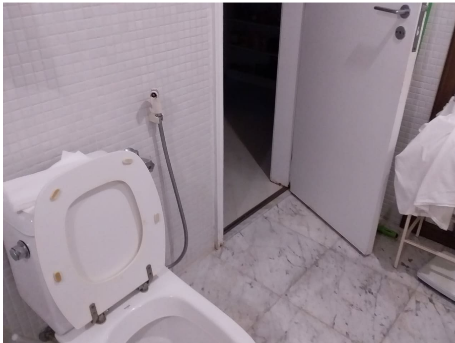
VISTA PARCIAL BANHEIRO Segundo o proprietário, vaso sanitário instalado em área pertencente ao apto. nº 2901 (imagem cedida pelo proprietário)
