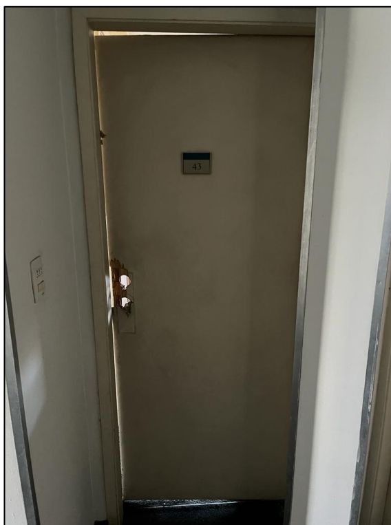
Foto 16 - Vista geral da porta de entrada do apartamento semelhante, nº 43.
