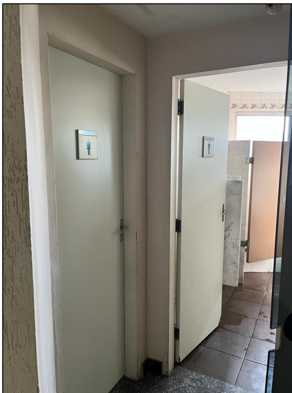
Foto 12 - Vista geral do banheiro do restaurante do Empreendimento.
