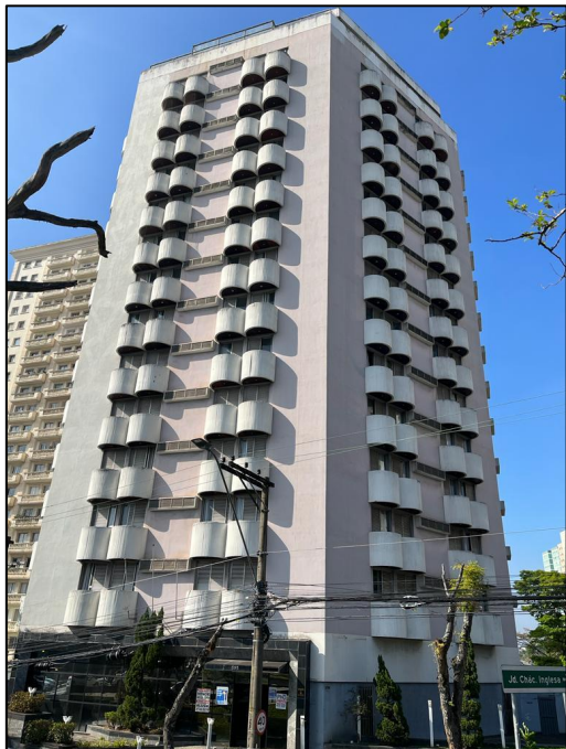
Foto 1 - Vista geral do acesso ao Condomínio Edifício Park Plaza Residence Service.
