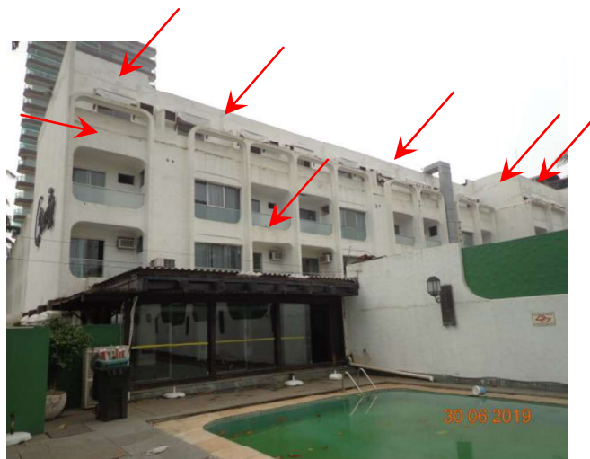
Fachadas externas de reparos de fissuras e umidade e, pintura.
