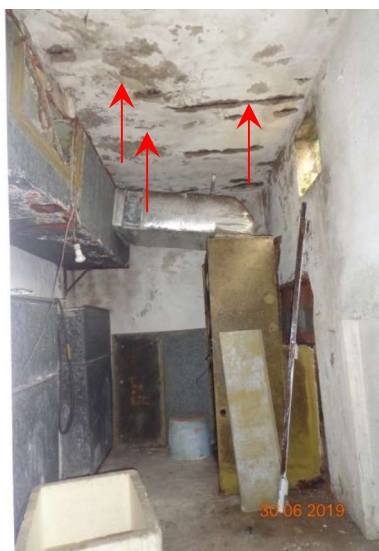
Galpão da lavanderia. Com várias infiltrações, pisos desgastados e soltos, telhas desgastadas e, quadro de luz com ferrugem.
