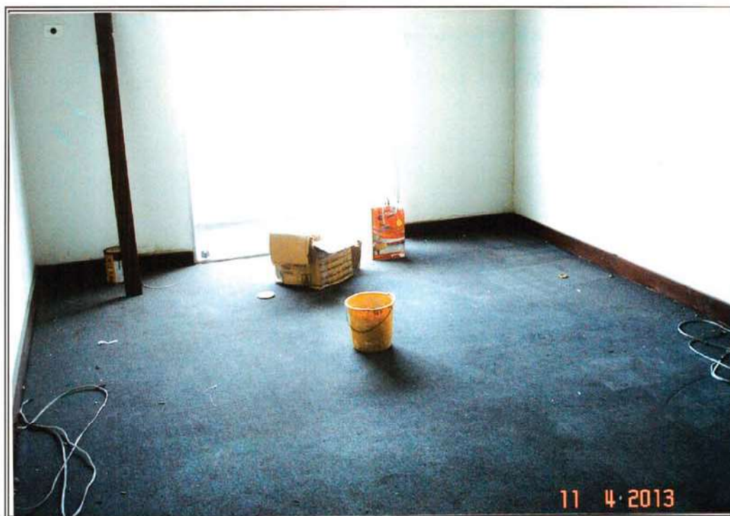
FOTO 128 - Vista do apartamento 421.
