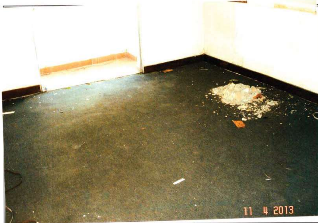
FOTO 138 - Vista de outro quarto do quarto andar.
