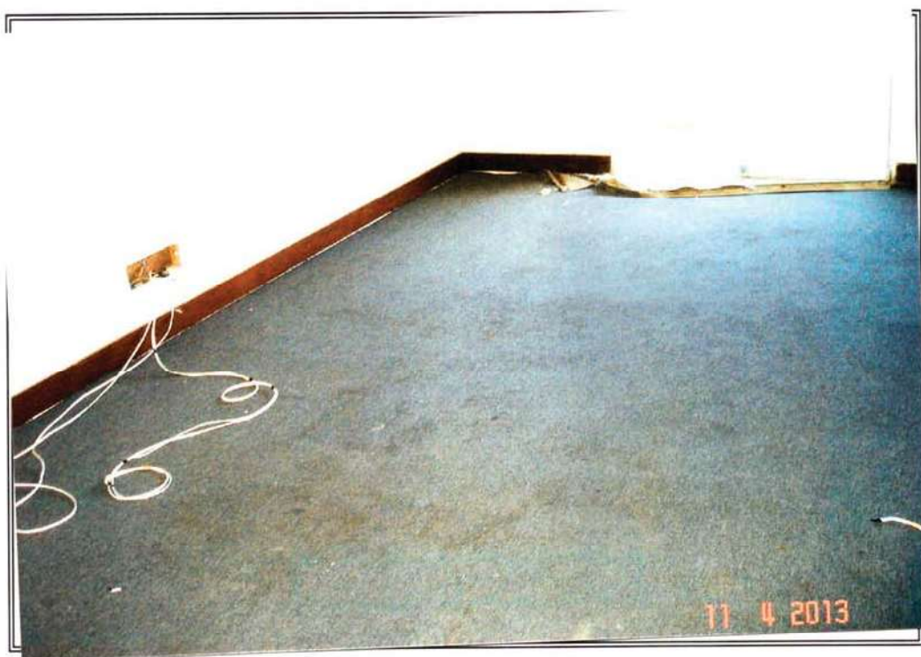
FOTO 131 - Vista do apartamento 431.
