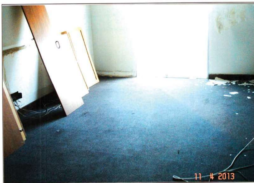
FOTO 129 - Vista do apartamento 422.
