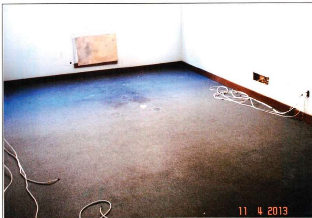
FOTO 133 - Vista do apartamento 411.
