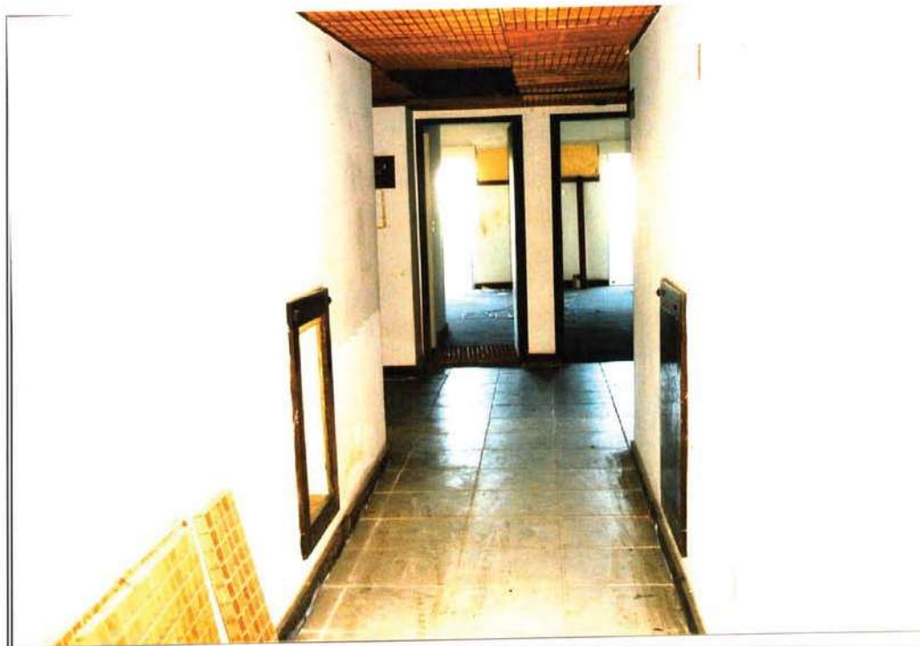
FOTO 140 – Outra vista do 4º andar, olhando em sentido à Rua Santa Rosa.
