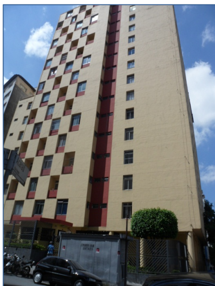
Foto 3 - Vista do Edifício Provença
