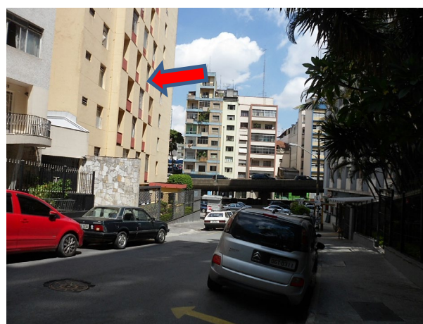
Foto 2 - Rua Acaraú onde se situa o edifício do apartamento objeto da penhora
