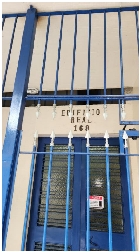
Vista parcial da entrada do imóvel
