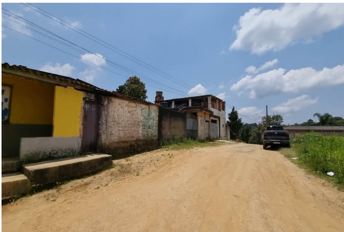
Foto nº 8: Vista da Rua Mato Grosso no dia da vistoria judicial realizada.
