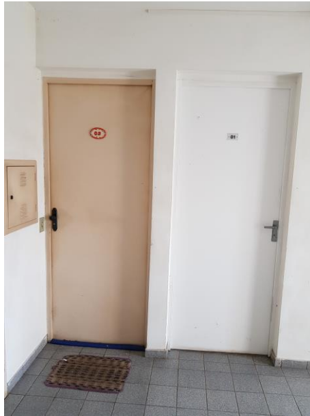
FOTO Nº 03 Vista parcial da entrada do apartamento 01 do Edifício Trancoso
