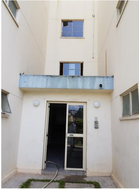
FOTO Nº 01 Vista parcial da fachada do Edifício Trancoso
