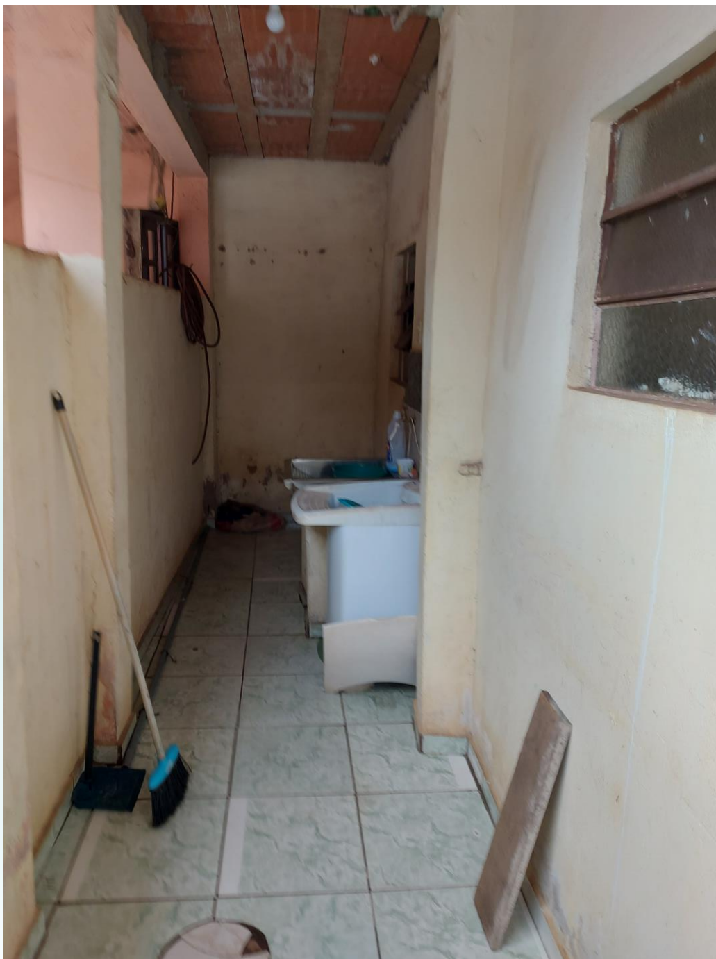
Entrada pela Lavanderia
