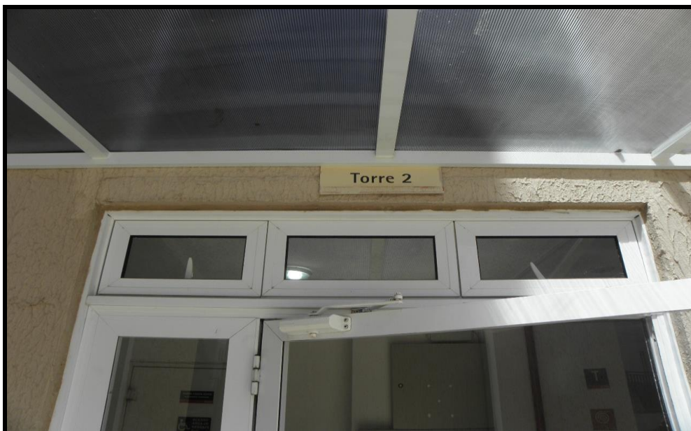
Foto: Entrada do Bloco 02, Condomínio Granada.
