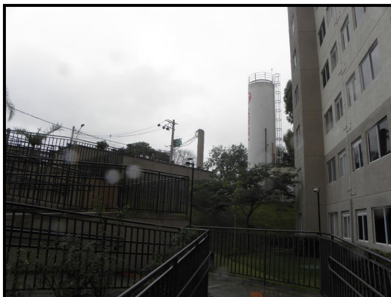
Foto: Caixa D'água do condomínio Granada.
