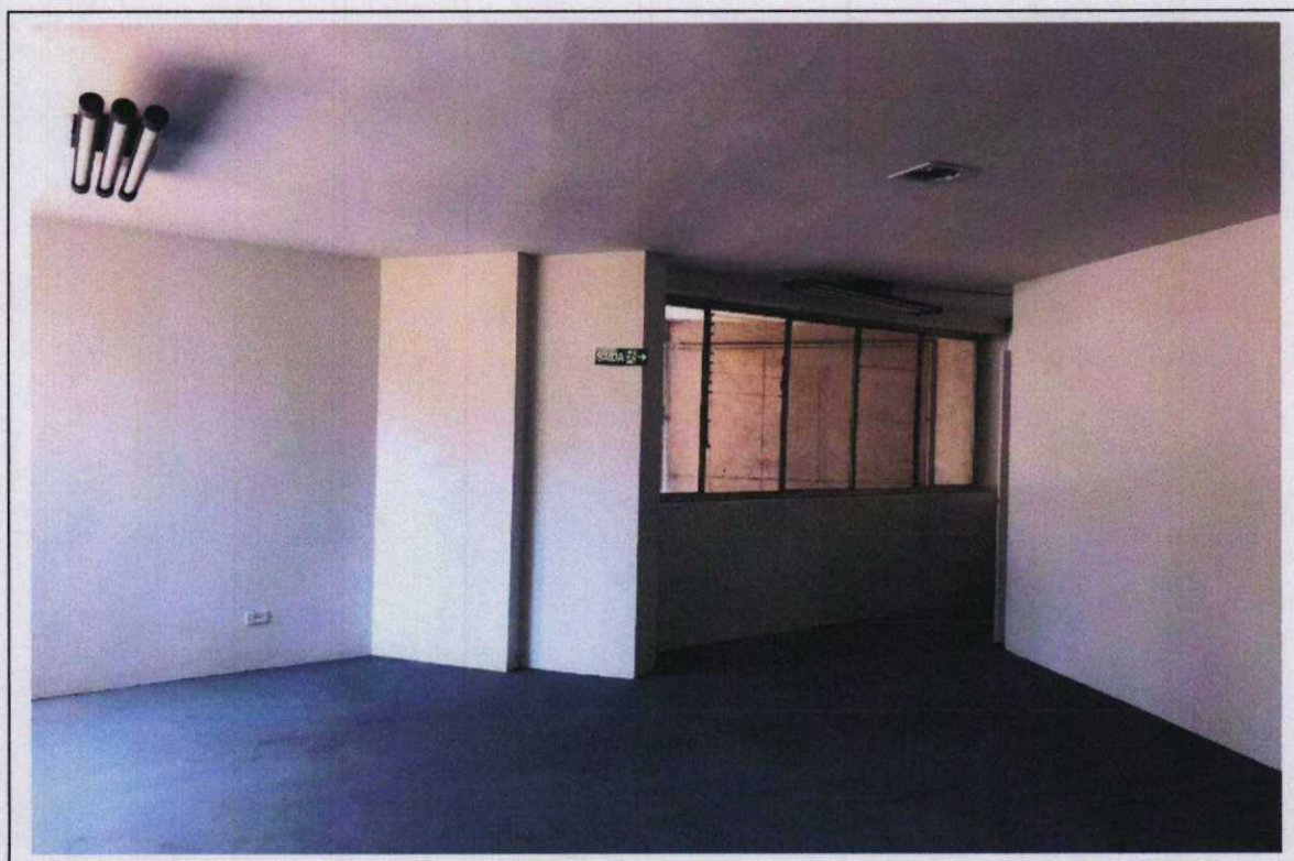
Foto 13: Vista de mais uma sala. Suas principais características construtivas são: piso em carpete, paredes revestidas em massa corrida pintadas em látex, forro em gesso e esquadrias de alumínio.
