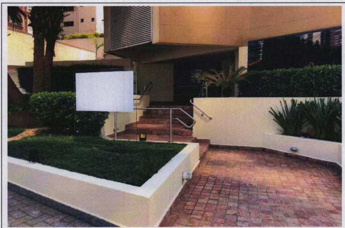
Foto 05: Vista do acesso para o interior do Edifício Palazzo Gritti onde se situa a sobreloja em estudo.
