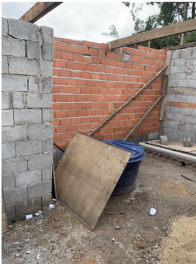
Foto n.º 11 – Vista interna da benfeitoria.
