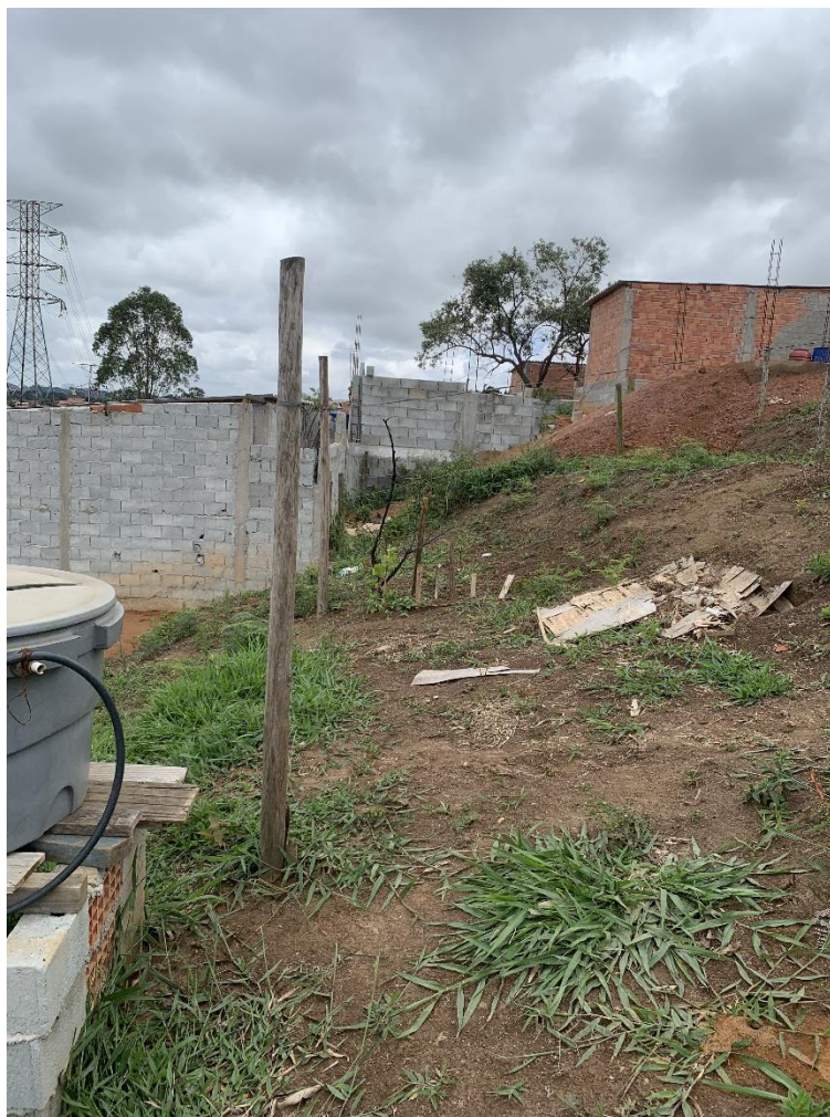
Foto nº. 9 – Vista da divisa lateral aos fundos do imóvel.
