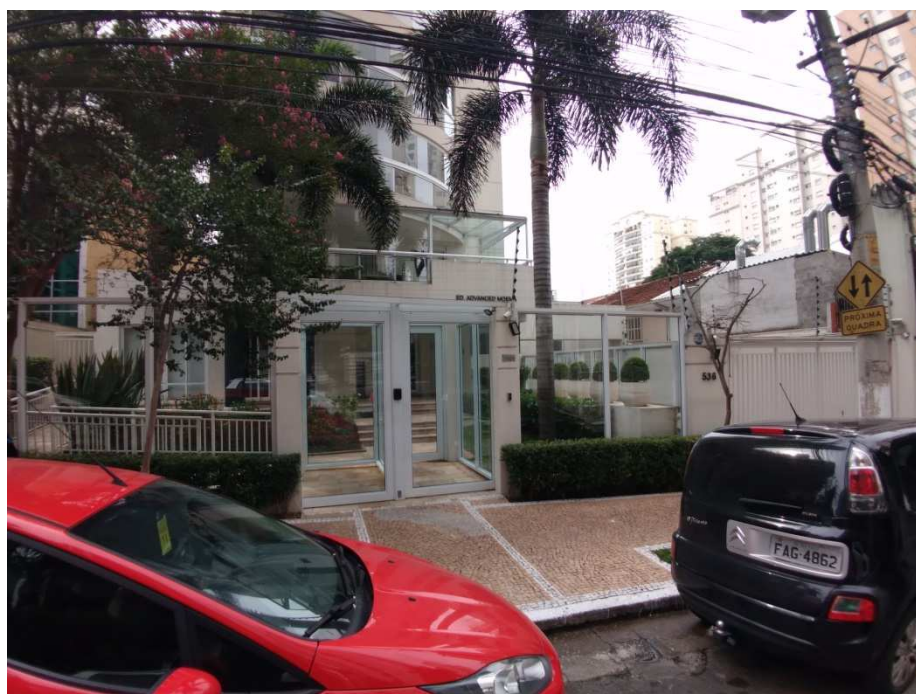
VISTA DA ENTRADA DO EDIFÍCIO.
