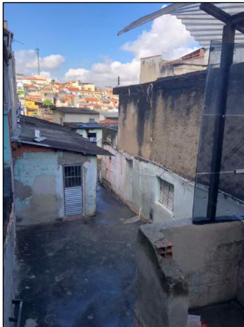
Foto 03 – Construções dentro do imóvel
