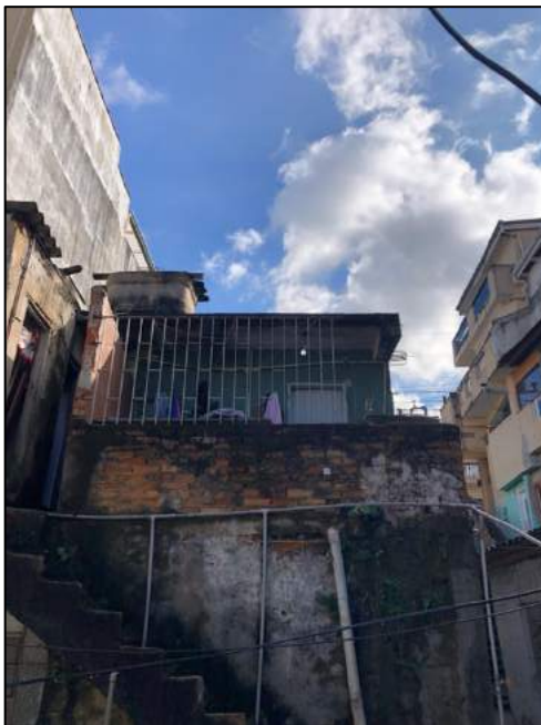
Foto 09 – Construções dentro do imóvel
