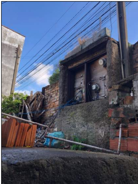
Foto 05 – Construções dentro do imóvel
