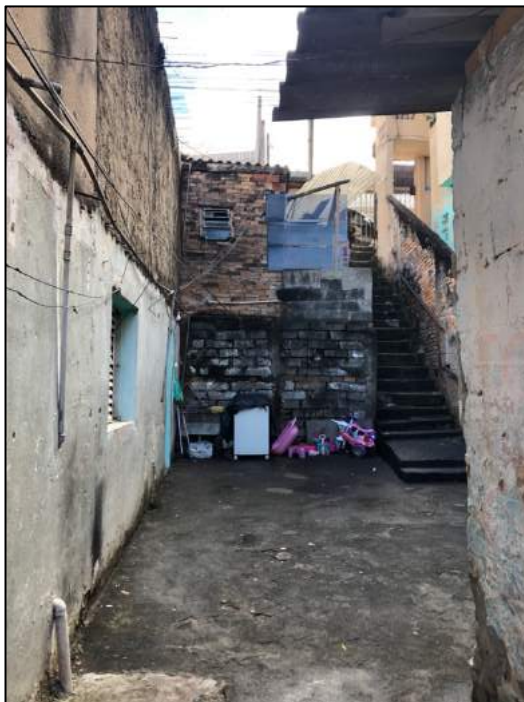
Foto 10 – Construções dentro do imóvel
