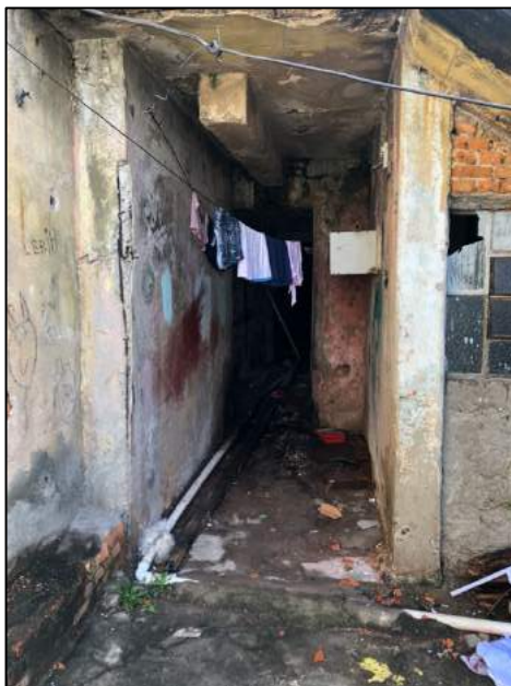
Foto 8 – Construções dentro do imóvel
