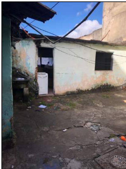
Foto 07 – Construções dentro do imóvel
