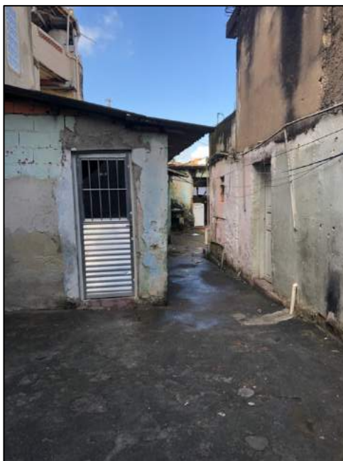
Foto 6 – Construções dentro do imóvel
