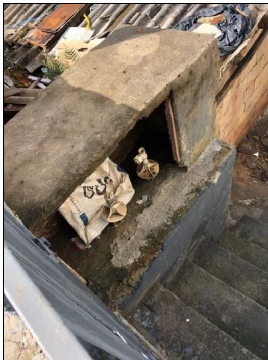
Foto 12 – Construções dentro do imóvel
