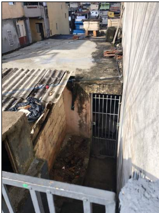
Foto 11 – Construções dentro do imóvel
