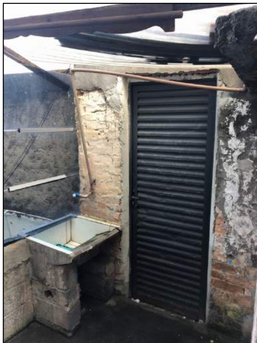
Foto 04 – Construções dentro do imóvel
