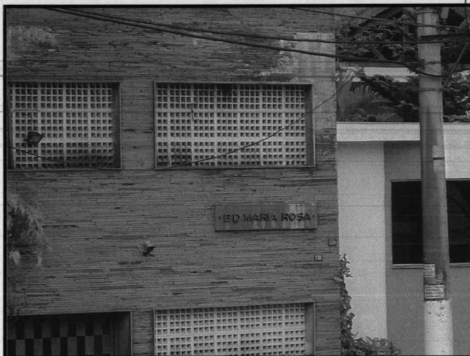
Fotografia 02 – Vista externa do imóvel
