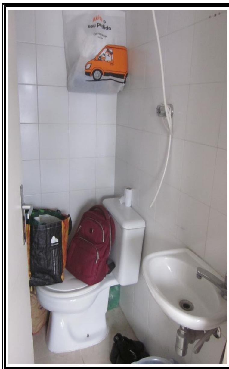
Foto nº 22: Vista do banheiro de serviço
