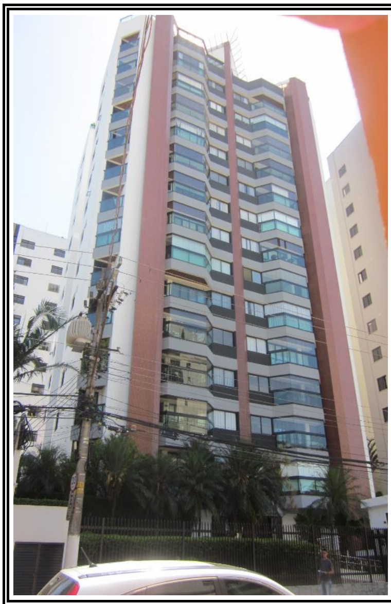
Foto nº 01: Vista geral da fachada do Edifício Moema San Sebastian
