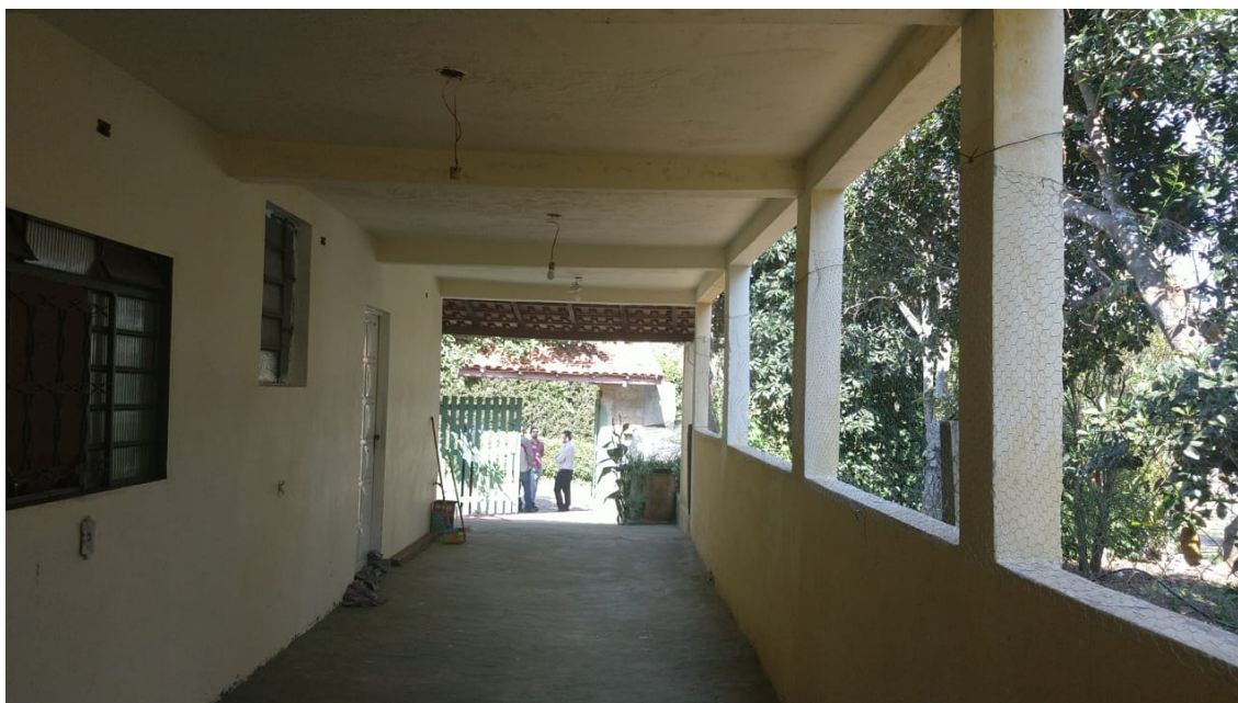
Foto 8 – Sacada na lateral da casa 1 no portão 1 do imóvel avaliando.
