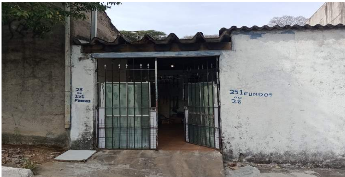
Foto 23 – (Fundos) – Acesso Principal
