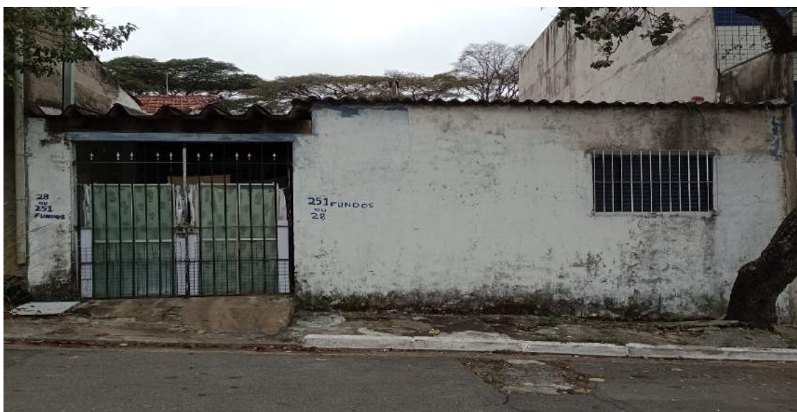
Foto 20 – Fundos do Imóvel - (Acesso pela Rua Francisco F. Rodrigues, 28)
