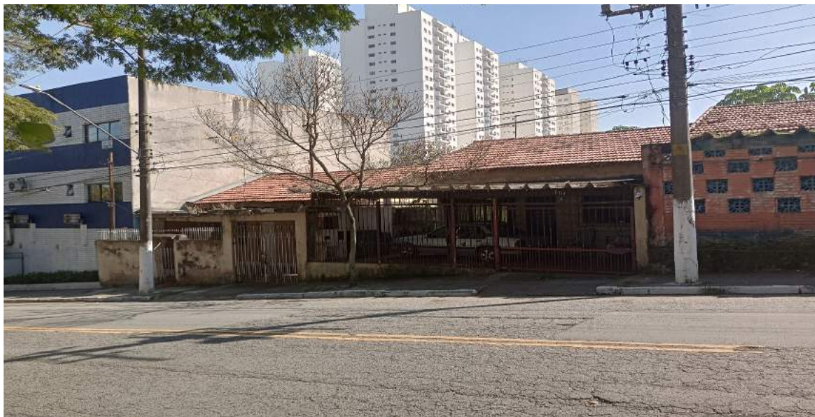
Foto 3 – Imóvel Vizinho (nº 259) à Direita
