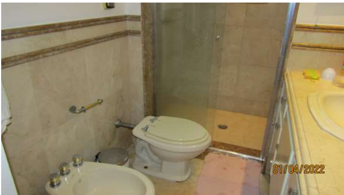
Foto 54 –Detalhes do banheiro 2 do apartamento 51.
