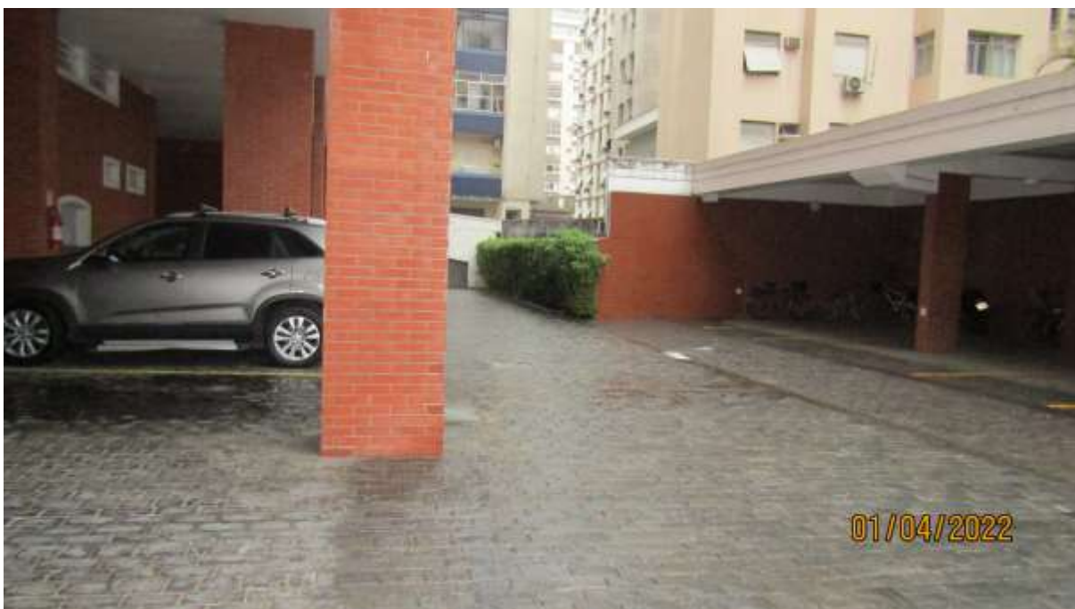
Foto 12 – Outra vista interna da garagem do Condomínio do Edifício Louvre.
