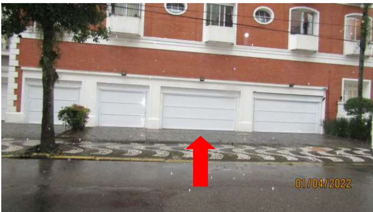
Foto 15 – Vista do portão de acesso às vagas da garagem fechada do apartamento avaliando.
