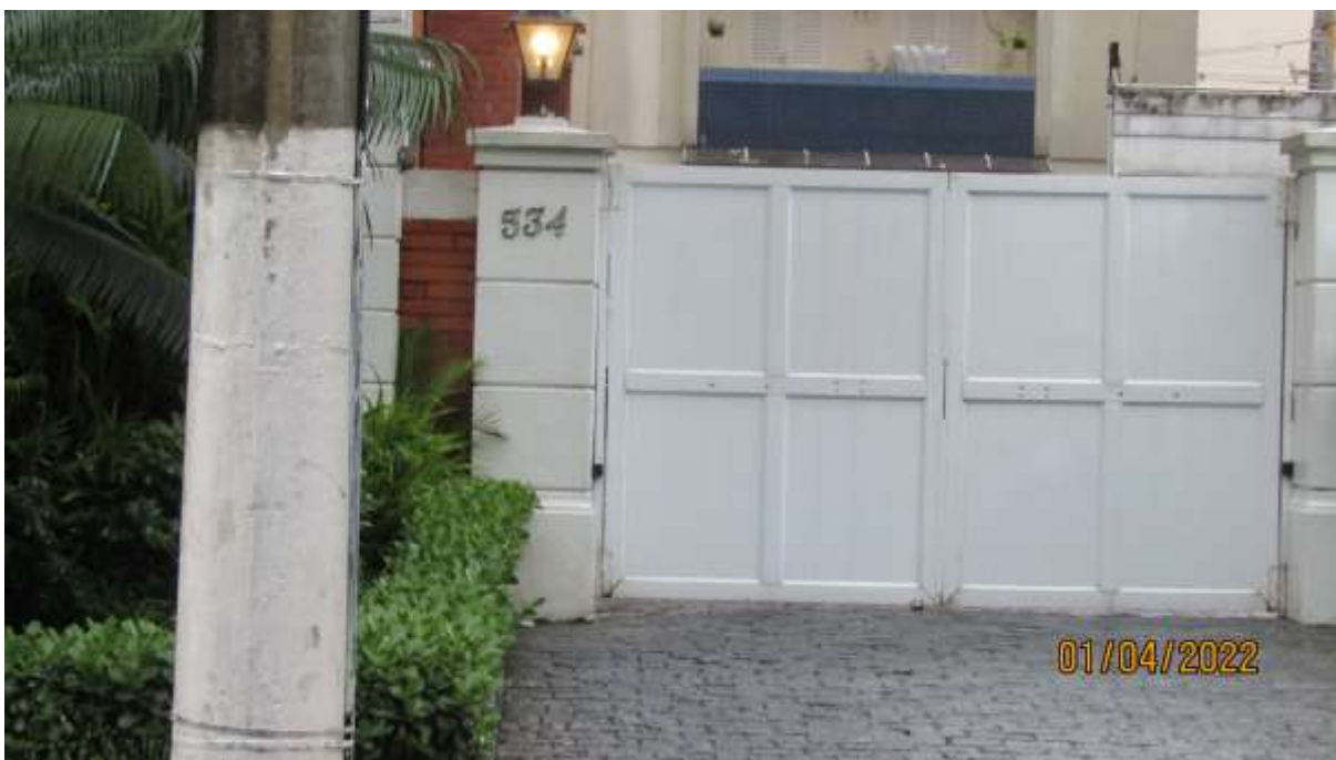
Foto 10 – Detalhes do portão de acesso à garagem.
