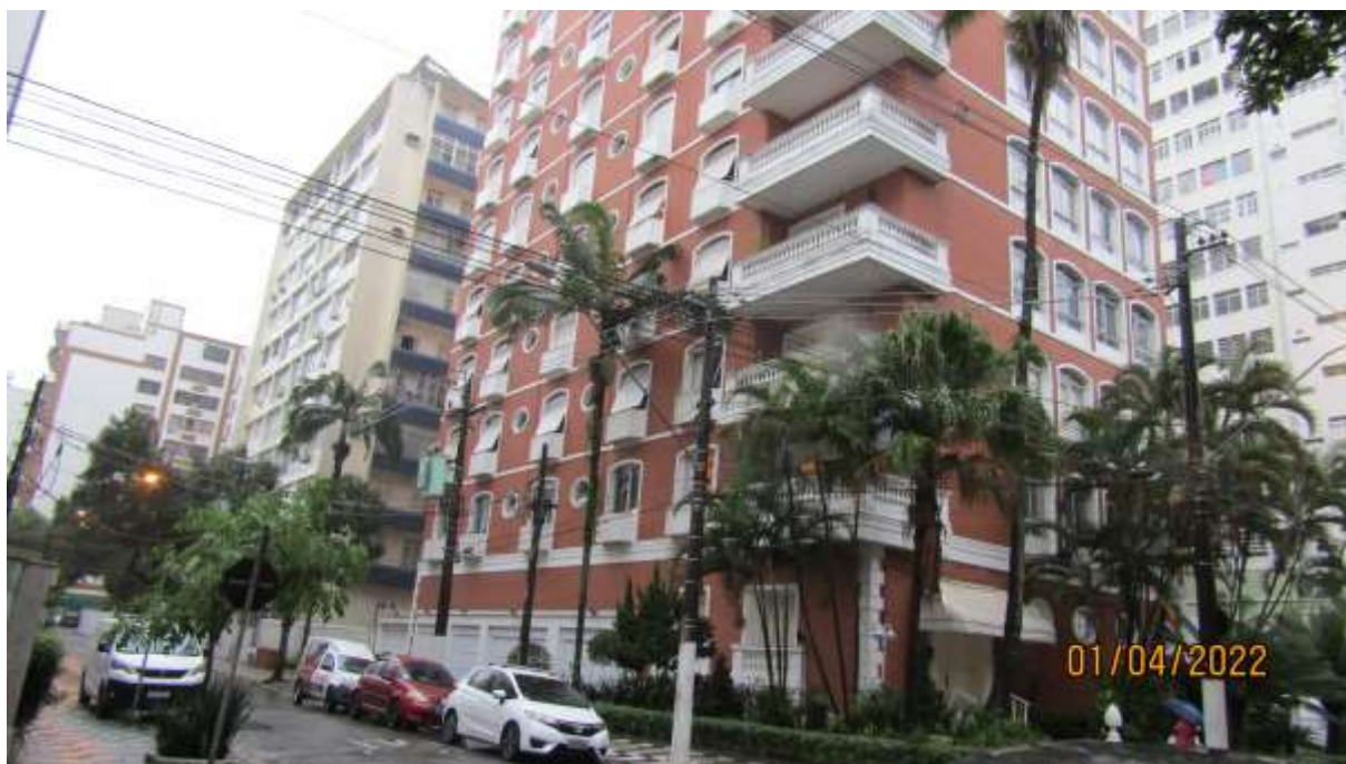
Foto 6 – Vista das fachadas frontal e lateral esquerda do Condomínio do Edifício Louvre.
