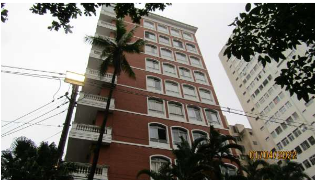
Foto 5 – Outra vista da fachada frontal do Condomínio do Edifício Louvre.
