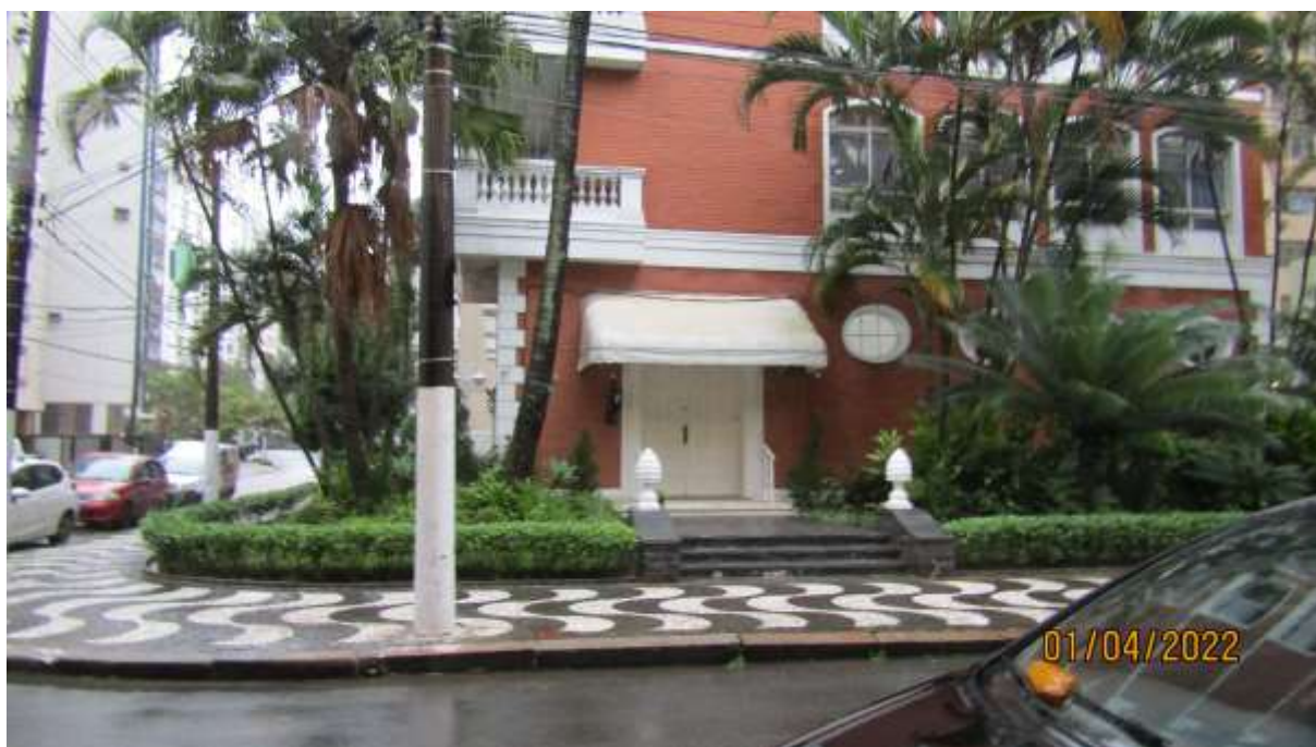
Foto 7 – Vista do acesso ao Condomínio do Edifício Louvre.
