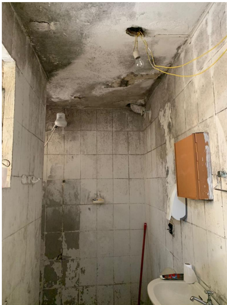
Foto nº. 15 – Vista do banheiro 1.
