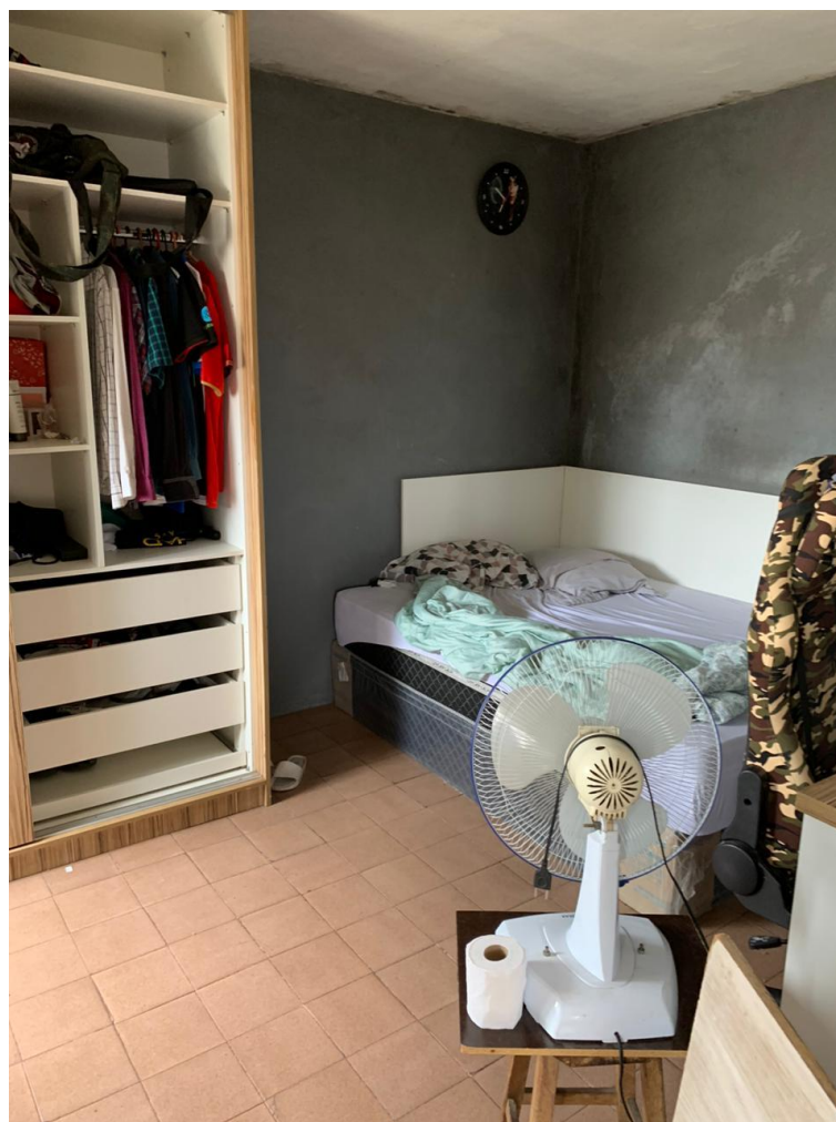
Foto nº. 26 – Outra vista do dormitório 4.
