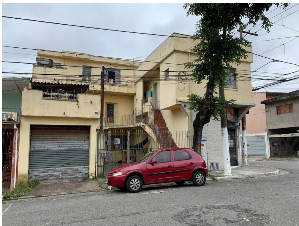
Foto nº. 7 – Vista da fachada do imóvel na Rua Paulo Florence.
