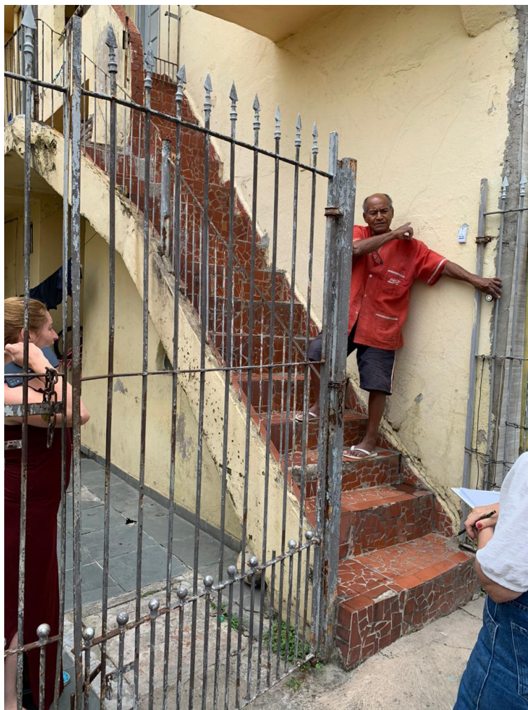
Foto nº. 16 – Vista da escada de acesso a residência 02.
