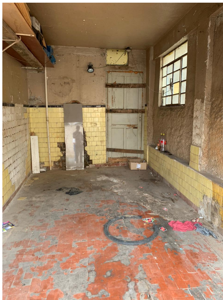
Foto nº. 29 – Vista da garagem coberta.
