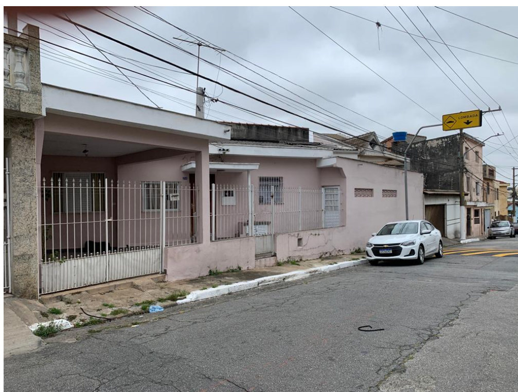
Foto n.º 3 – Vista da fachada do imóvel avaliando.
