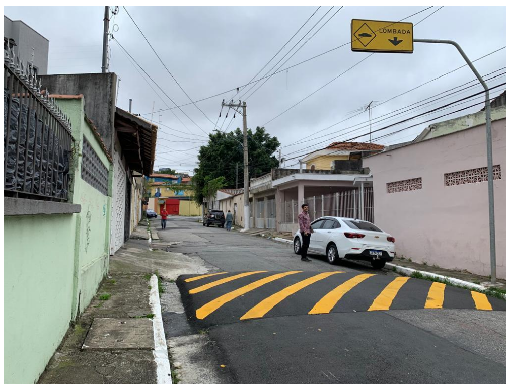
Foto nº. 2 – Outra vista da Rua Fábio.
