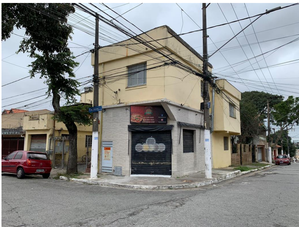
Foto nº. 5 – Vista da fachada do imóvel avaliando.
