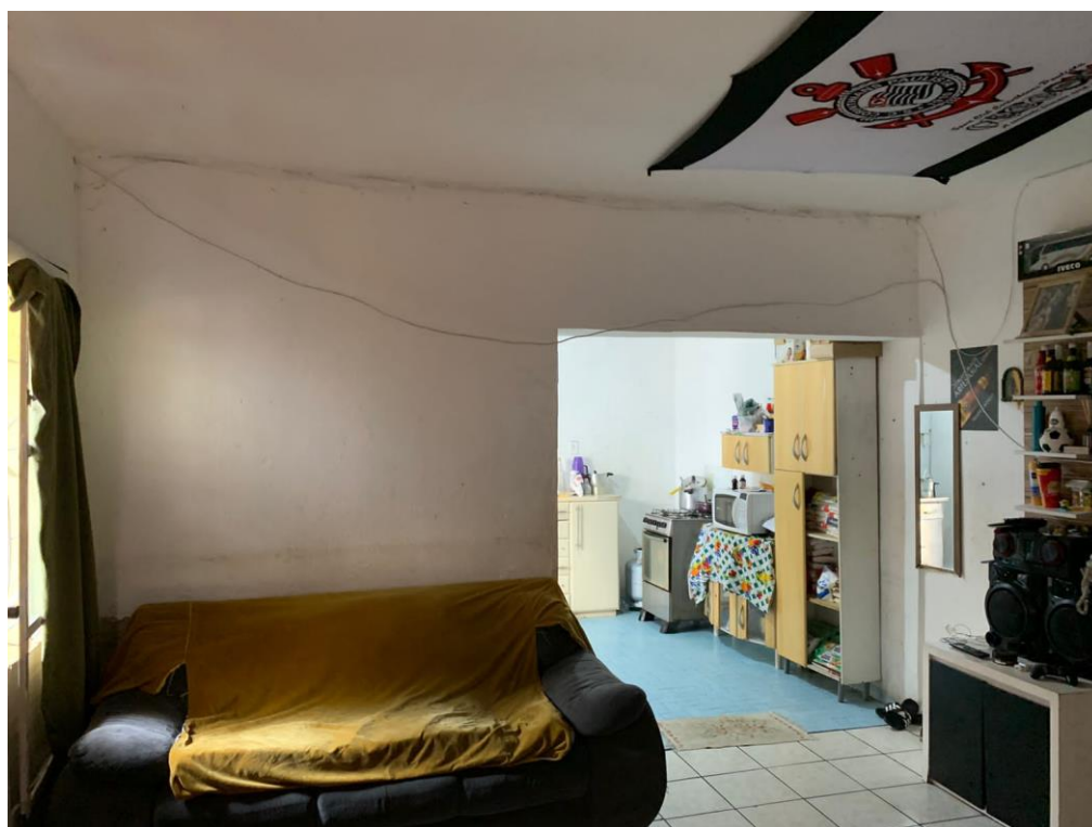
Foto nº. 11 – Outra vista da sala 1.
