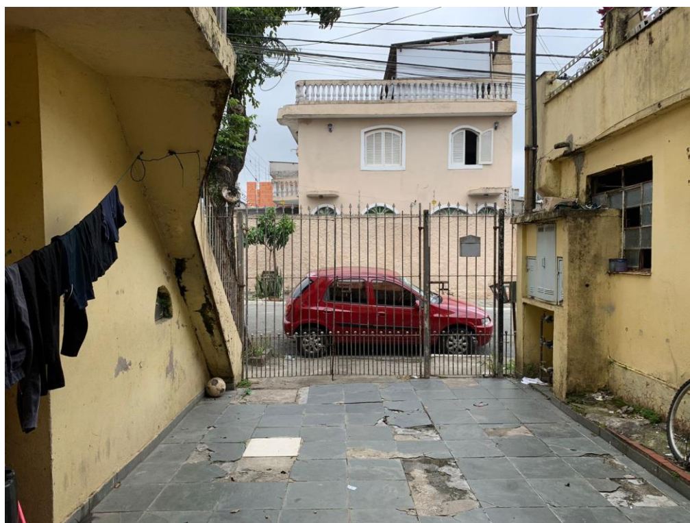
Foto nº. 8 – Vista da garagem descoberta.
