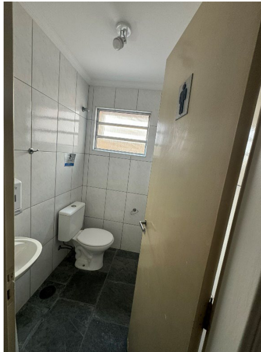
Foto 7 – Edifício Montegiordano – SALÃO DE FESTAS – Banheiro Masculino
