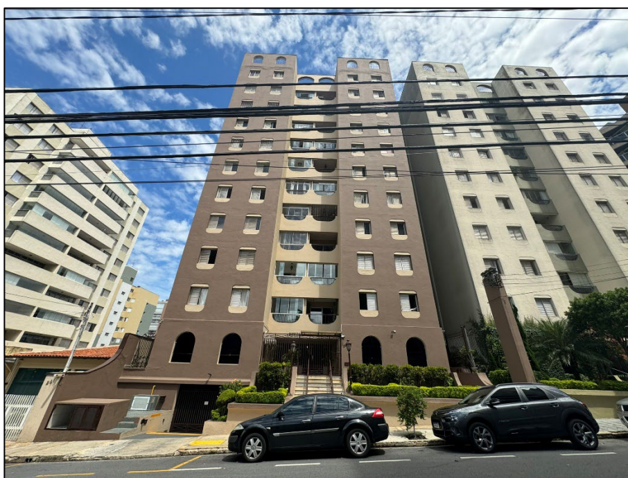
Foto 2 – Rua Gonçalves Dias, 295 – Edifício Montegiordano – FACHADA
