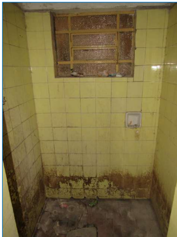
OUTRA VISTA DO BANHEIRO.
