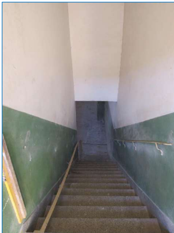
ESCADA DE ACESSO.
