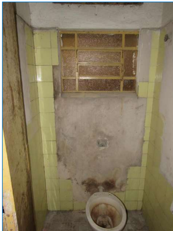
OUTRA VISTA DO BANHEIRO.
