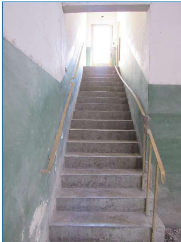
OUTRA VISTA DA ESCADA DE ACESSO.
