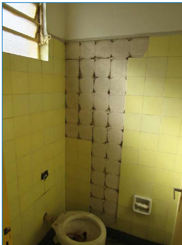
OUTRA VISTA DO BANHEIRO.
