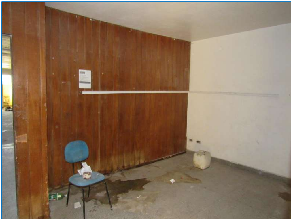
ASPECTOS GERAIS DA SALA.
