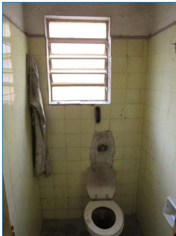
OUTRA VISTA DO BANHEIRO.
