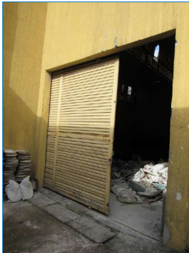
ACESSO AO GALPÃO.
