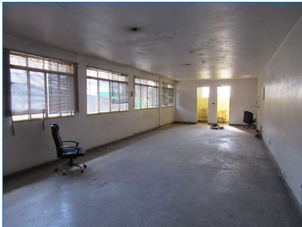
ASPECTOS GERAIS DA SALA.
