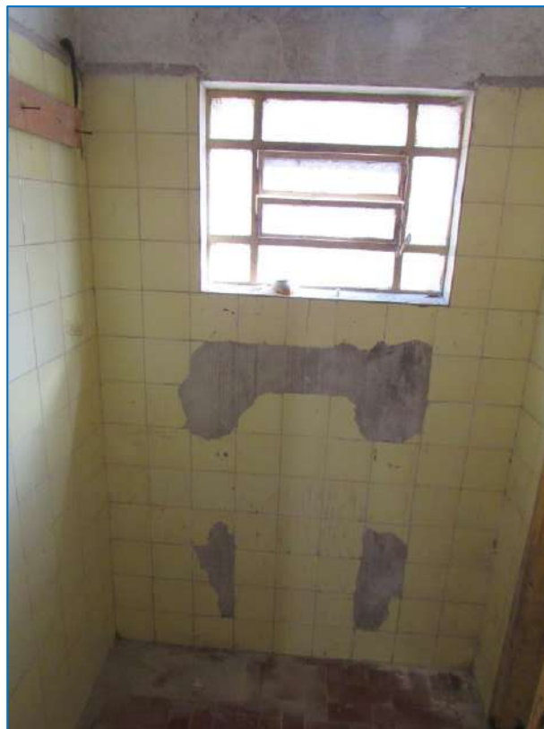
OUTRA VISTA DO BANHEIRO.
