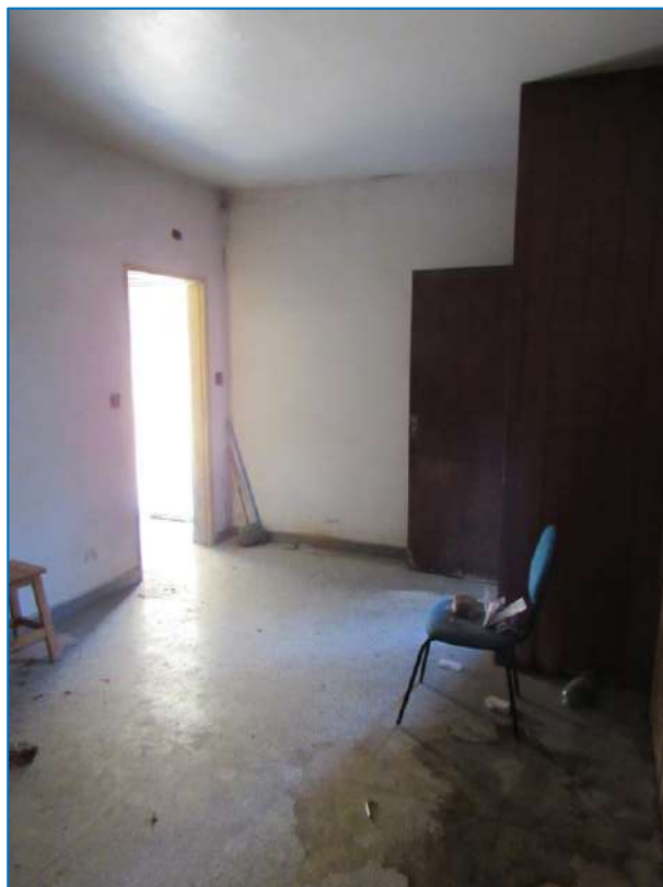
ASPECTOS GERAIS DA SALA.
