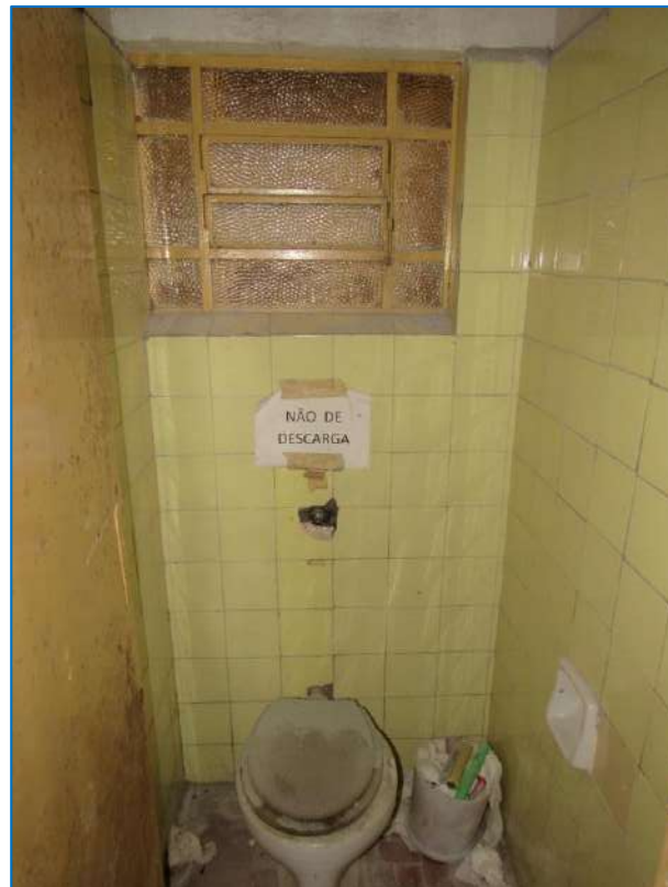
OUTRA VISTA DO BANHEIRO.
