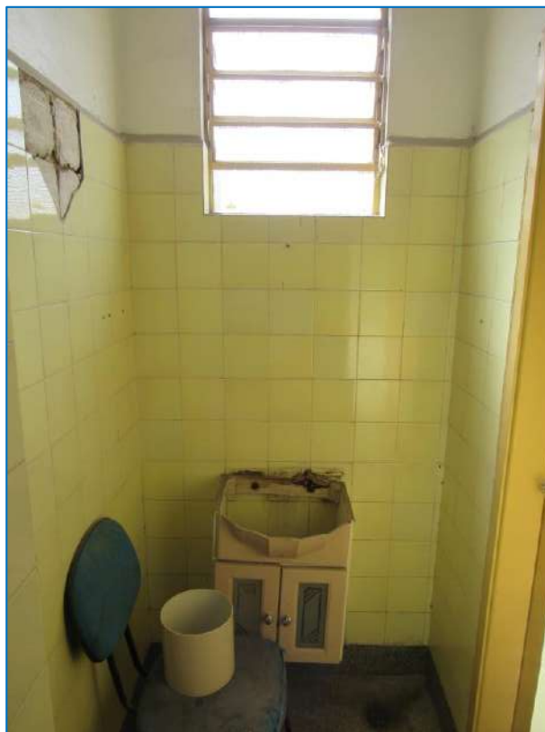
OUTRA VISTA DO BANHEIRO.
