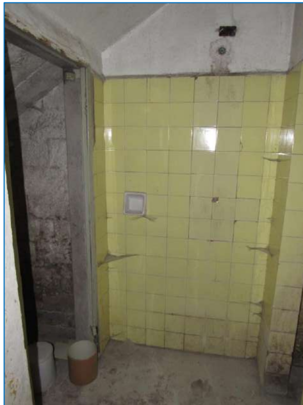
OUTRA VISTA DO BANHEIRO.
