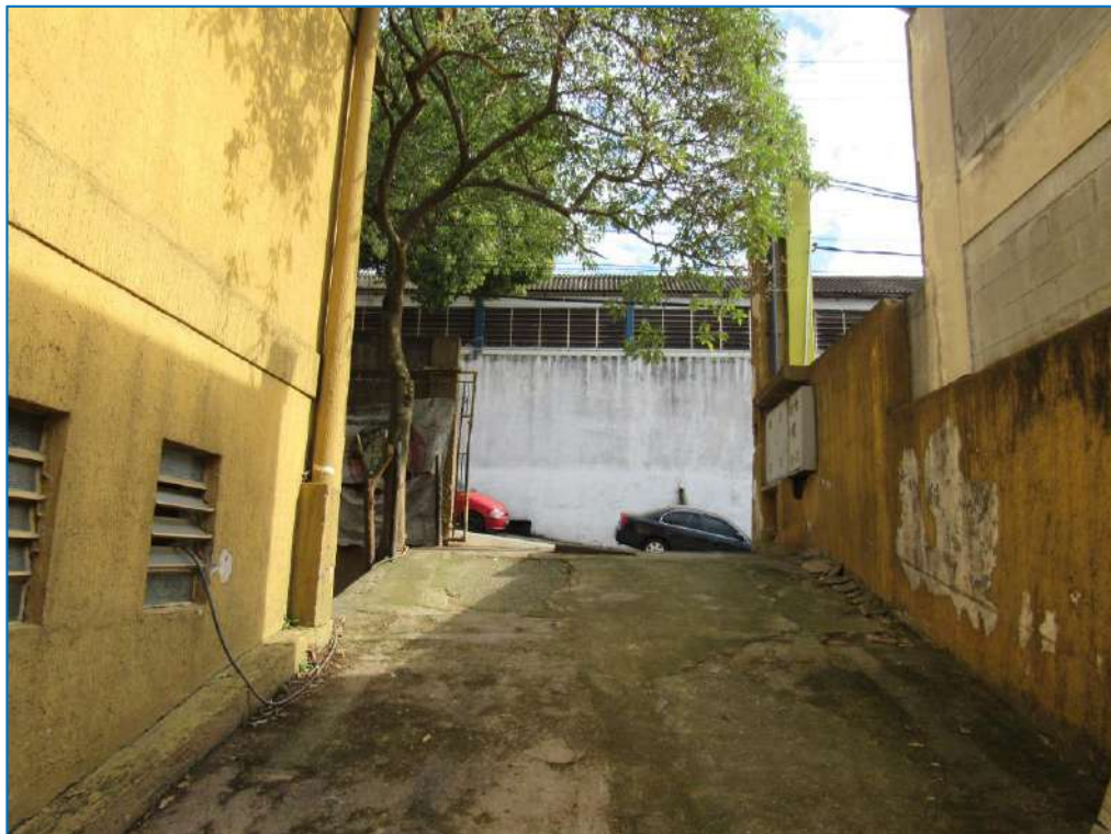
OUTRA VISTA DA RAMPA.
