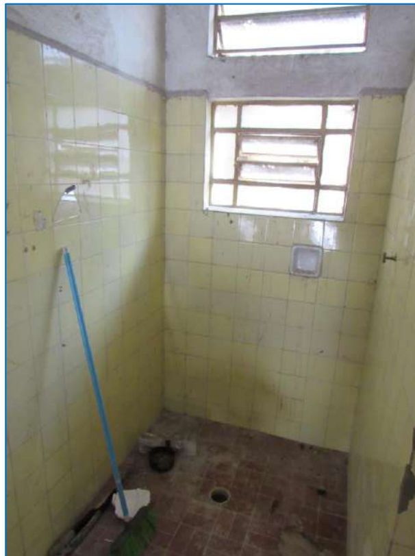
OUTRA VISTA DO BANHEIRO.
