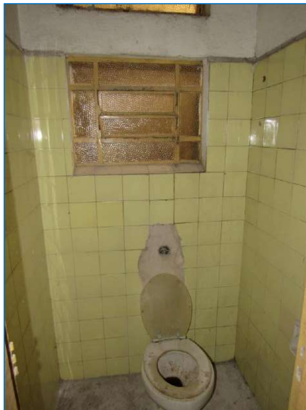
OUTRA VISTA DO BANHEIRO.
