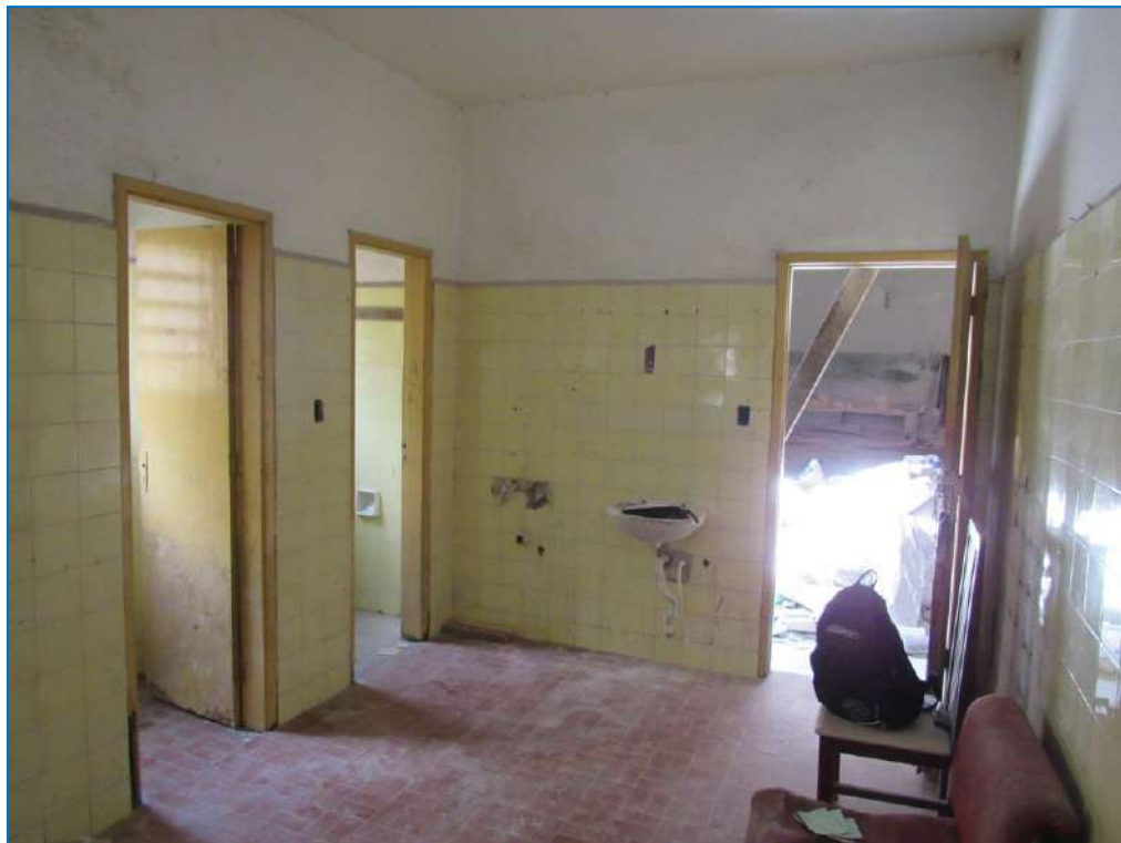
OUTRA VISTA DO BANHEIRO.
