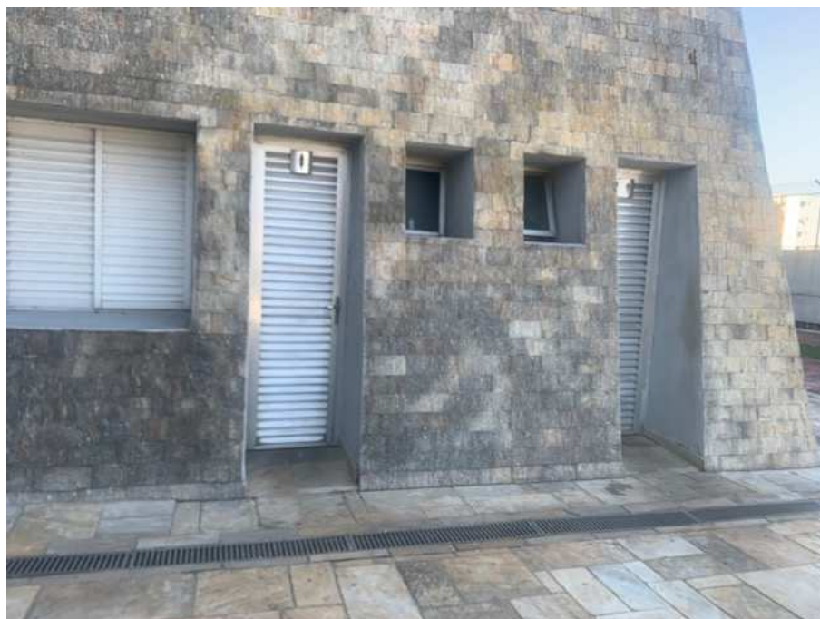
FOTO N ° 17 VISTA DO ACESSO AOS BANHEIROS FEMININO E MASCULINO
