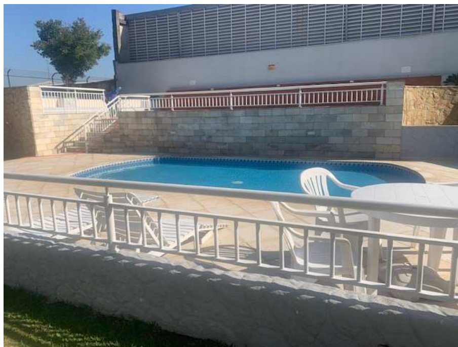
FOTO N ° 10 VISTA DA PISCINA INFANTIL
