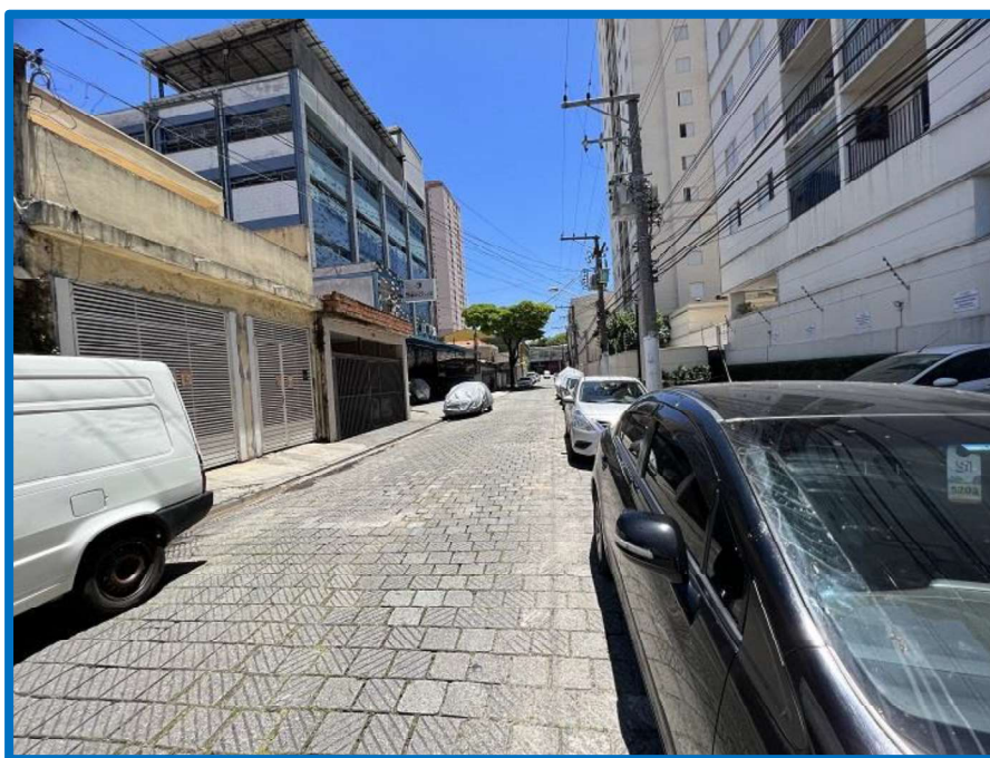
FOTO 01: Rua do imóvel avaliando.
