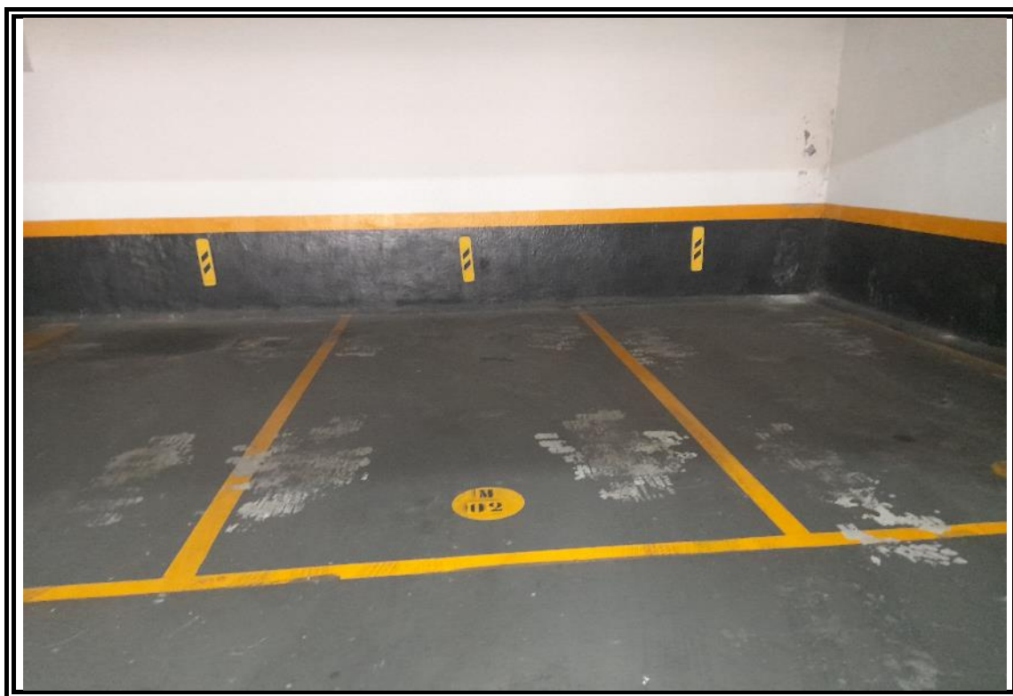
Foto nº 23: Aspecto geral das vagas da garagem cobertas (subsolo)
