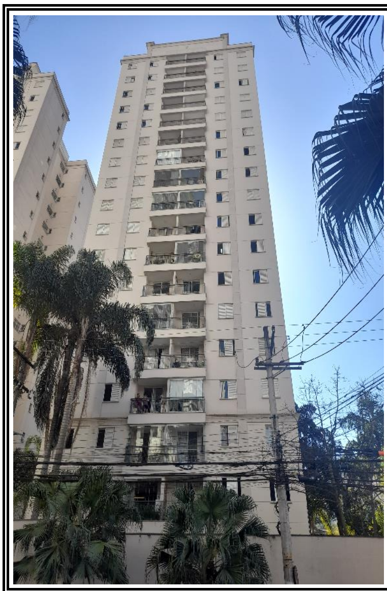
Foto nº 05: Vista do Bloco 02, onde se encontra o imóvel avaliando
