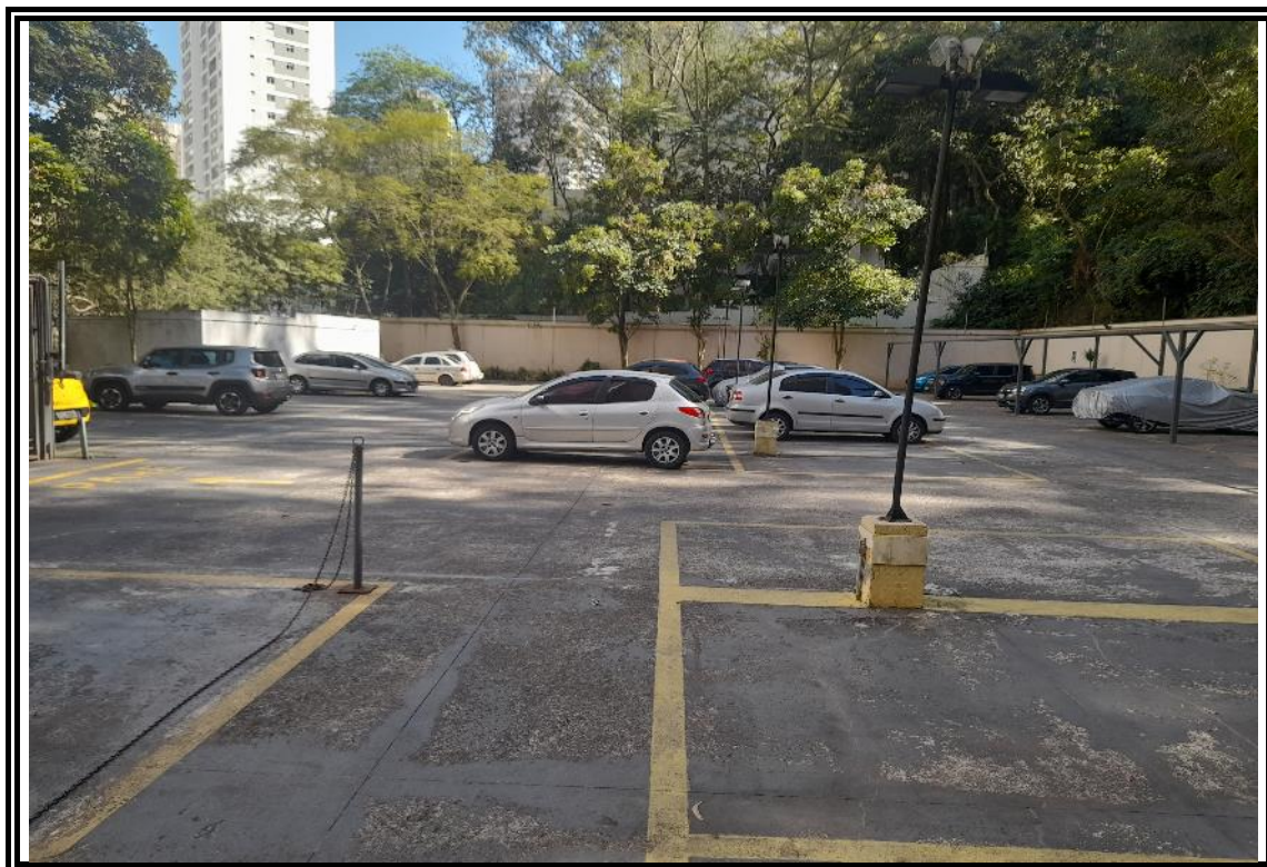
Foto nº 20: Vista geral da garagem descoberta (pavimento térreo)
