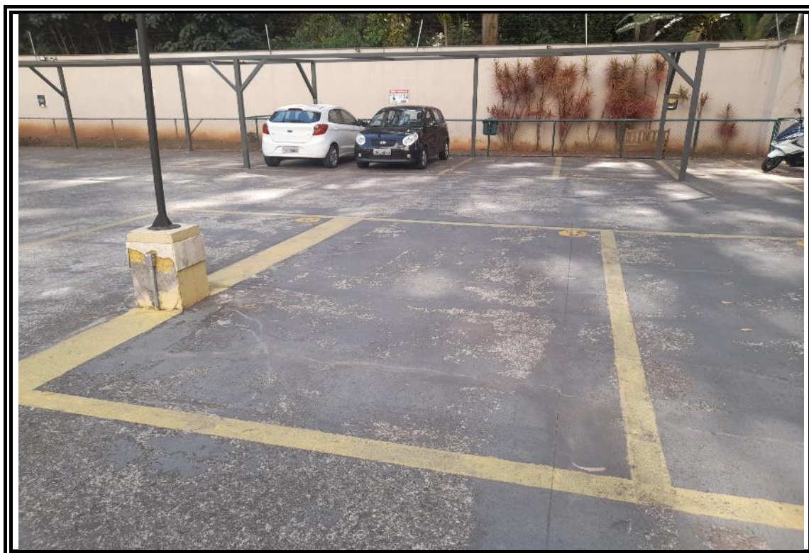
Foto nº 21: Aspecto geral das vagas da garagem descobertas (pavimento térreo)
