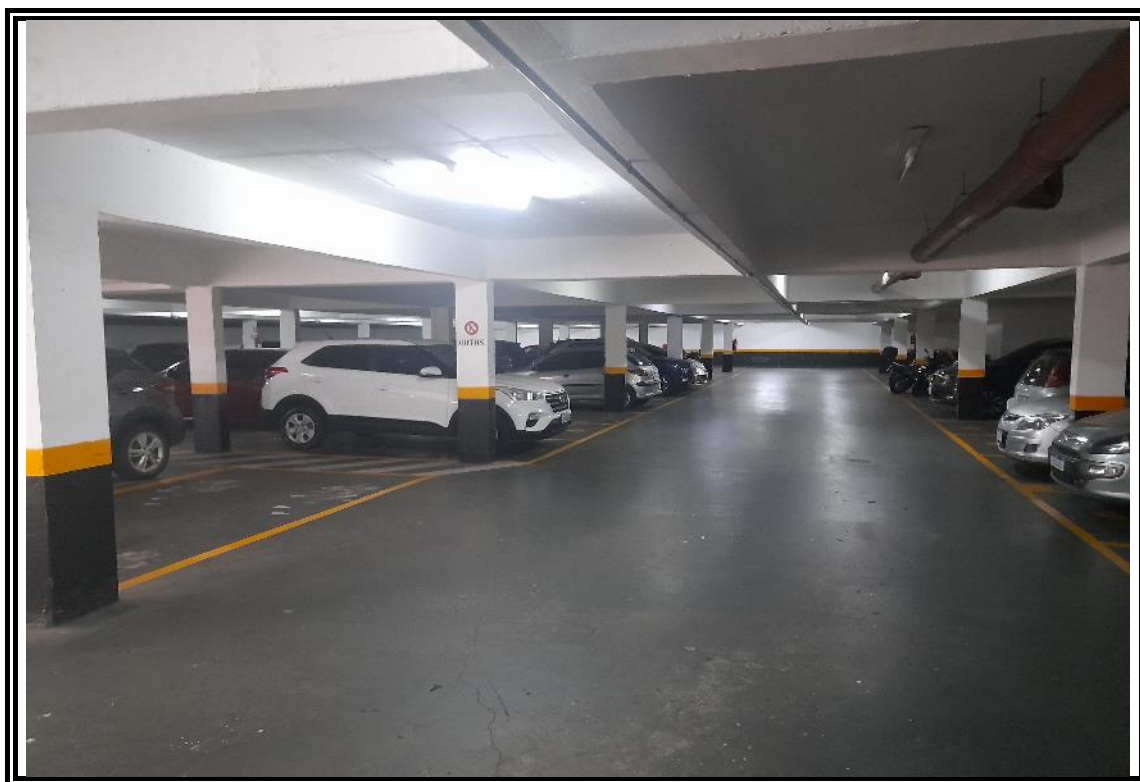
Foto nº 22: Vista geral da garagem coberta (subsolo)
