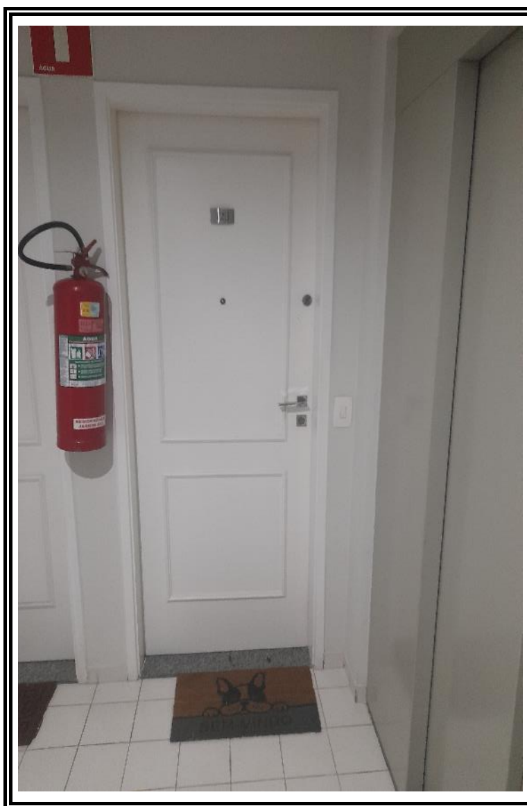
Foto nº 09: Vista do hall de entrada do imóvel vistoriado (apto. nº 123 – Bloco 02), utilizado como paradigma na presente avaliação
