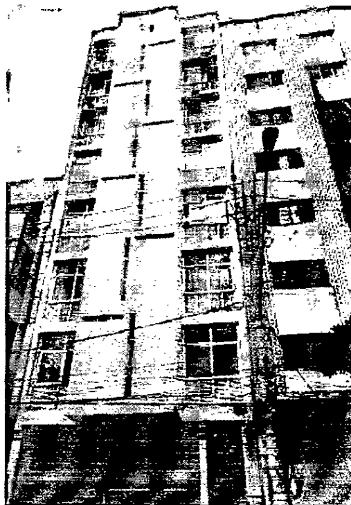
Foto nº 2 – Vista frontal do imóvel.
