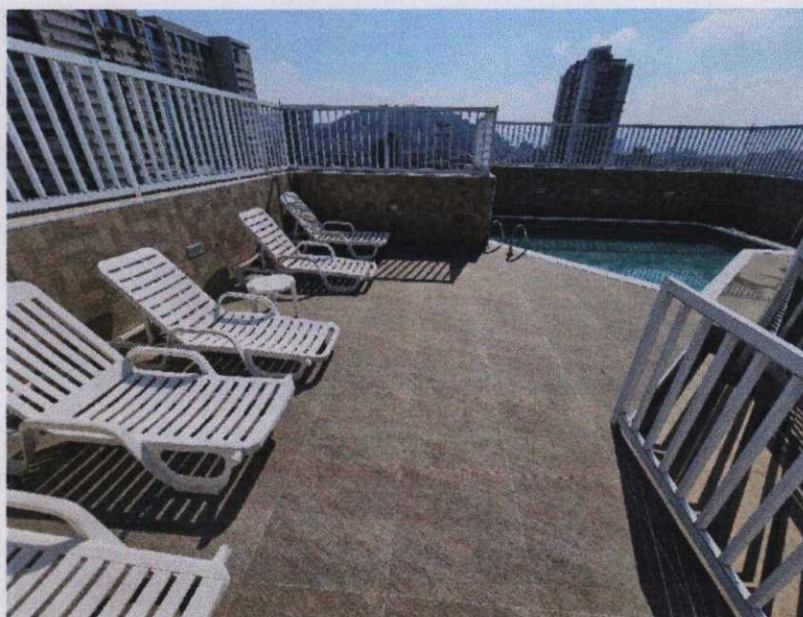
Foto 15 – Vista da área da piscina no 10º andar apresentando os seguintes padrões construtivos: piso e alvenarias em revestimento cerâmico; gradis em alumínio.
