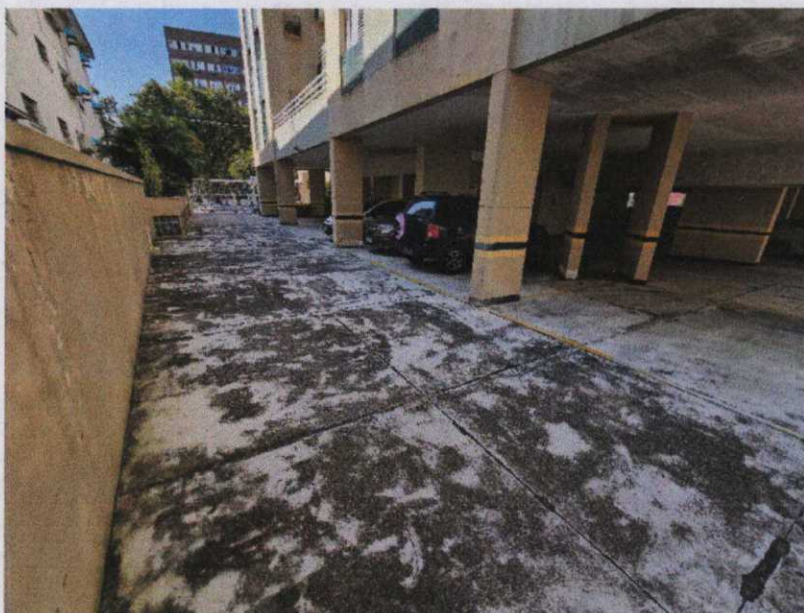
Foto 20 – Vista do recuo lateral direito do edifício.
