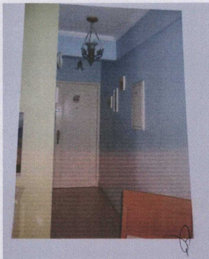
Foto 32 – Vista do hall de entrada do apartamento avaliando apresentando os seguintes padrões construtivos: piso em revestimento cerâmico; alvenarias e teto revestidos em pintura látex pva acrílica sobre massa fina com detalhes em gesso; porta em madeira. (FOTO EXTRAÍDA DO LAUDO ACOSTADO ÀS FLS. 340/399 DOS AUTOS)
