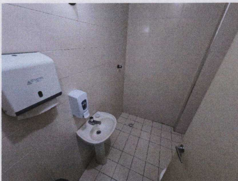
Foto 10 – Vista do banheiro masculino localizado no 10º andar apresentando os seguintes padrões construtivos: piso e alvenarias em revestimento cerâmico, teto revestido em pintura látex pva acrílica sobre massa fina; porta em madeira.
