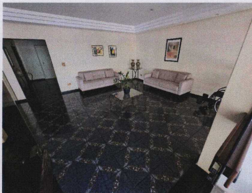
Foto 23 – Vista do saguão de entrada do edifício, no pavimento térreo apresentando os seguintes padrões construtivos: piso em revestimento cerâmico; alvenarias e teto em pintura látex pva acrílica sobre massa fina e detalhes em gesso; porta em vidro e esquadrias em alumínio.
