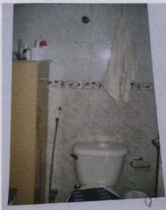
Foto 40 – Vista do banheiro do apartamento avaliando apresentando os seguintes padrões construtivos: piso e alvenarias em revestimento cerâmico; teto revestido em pintura látex pva acrílica sobre massa fina com detalhes em gesso; esquadrias em alumínio. (FOTO EXTRAÍDA DO LAUDO ACOSTADO ÀS FLS. 340/399 DOS AUTOS)
