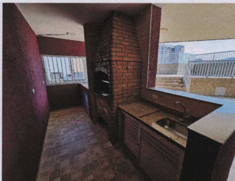
Foto 13 – Vista do espaço gourmet na área de lazer no 10º andar apresentando os seguintes padrões construtivos: alvenarias em pintura látex pva acrílica sobre massa texturizada; teto em pintura látex pva acrílica sobre massa fina; esquadrias em alumínio.
