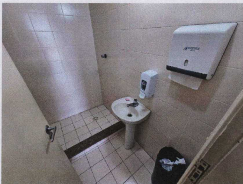
Foto 8 – Vista do banheiro feminino localizado no 10º andar apresentando os seguintes padrões construtivos: piso e alvenarias em revestimento cerâmico, teto revestido em pintura látex pva acrílica sobre massa fina; porta em madeira.
