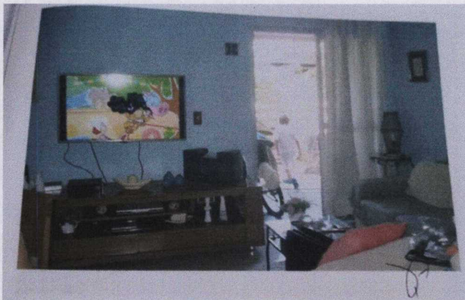
Foto 33 – Vista da sala de estar do apartamento avaliando apresentando os seguintes padrões construtivos: piso em revestimento cerâmico; alvenarias e teto revestidos em pintura látex pva acrílica sobre massa fina com detalhes em gesso; esquadrias em alumínio. (FOTO EXTRAÍDA DO LAUDO ACOSTADO ÀS FLS. 340/399 DOS AUTOS)
