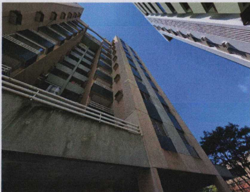
Foto 19 – Vista da fachada dos fundos do edifício.
