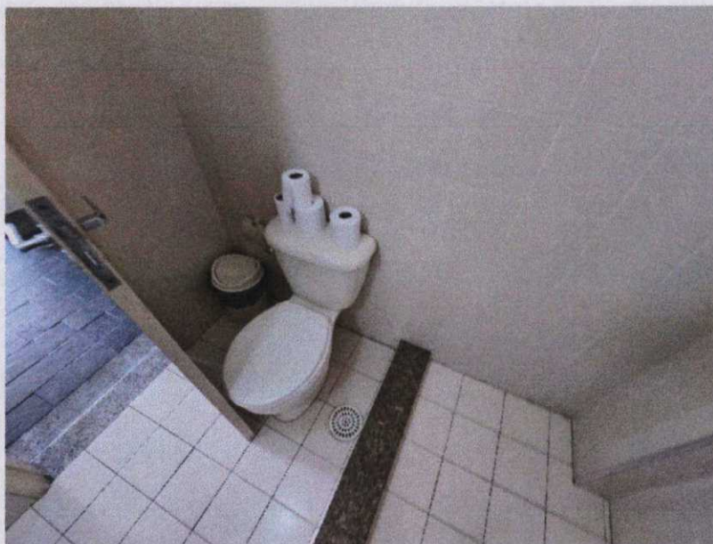
Foto 9 – Vista do banheiro feminino localizado no 10º andar apresentando os seguintes padrões construtivos: piso e alvenarias em revestimento cerâmico, teto revestido em pintura látex pva acrílica sobre massa fina; porta em madeira.
