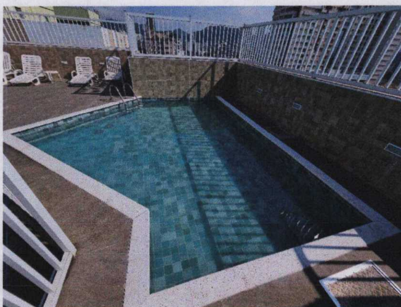
Foto 16 – Vista da piscina no 10º andar apresentando os seguintes padrões construtivos: piso e alvenarias em revestimento cerâmico; bordas em pedra natural.
