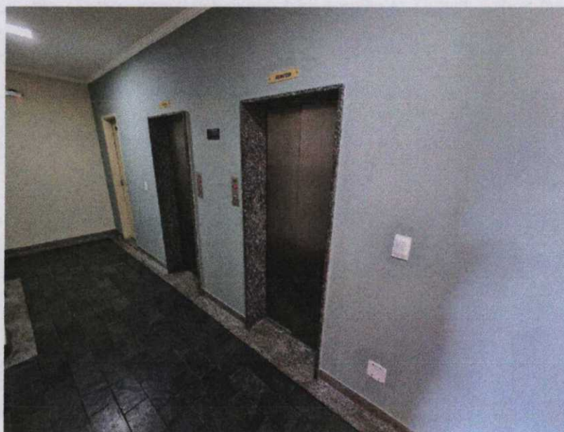
Foto 7 – Vista dos dois elevadores da edificação, social e serviço.
