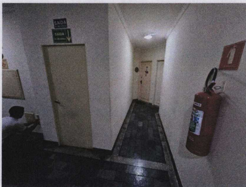
Foto 30 – Vista do corredor de circulação interna do 1º andar apresentando os seguintes padrões construtivos: piso revestido em pedras naturais; alvenaria e teto em pintura látex pva acrílica sobre massa fina com detalhes em gesso.
