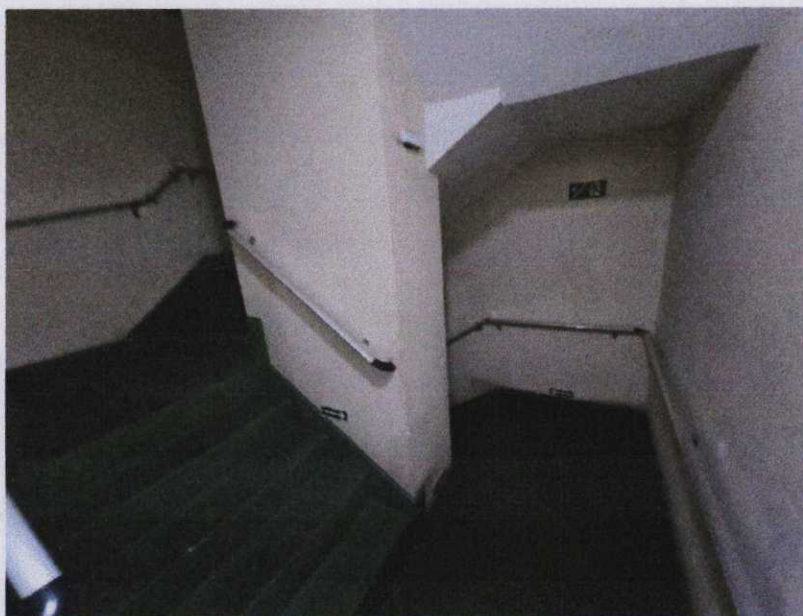
Foto 31 – Vista da escada de rota de fuga do edifício.
