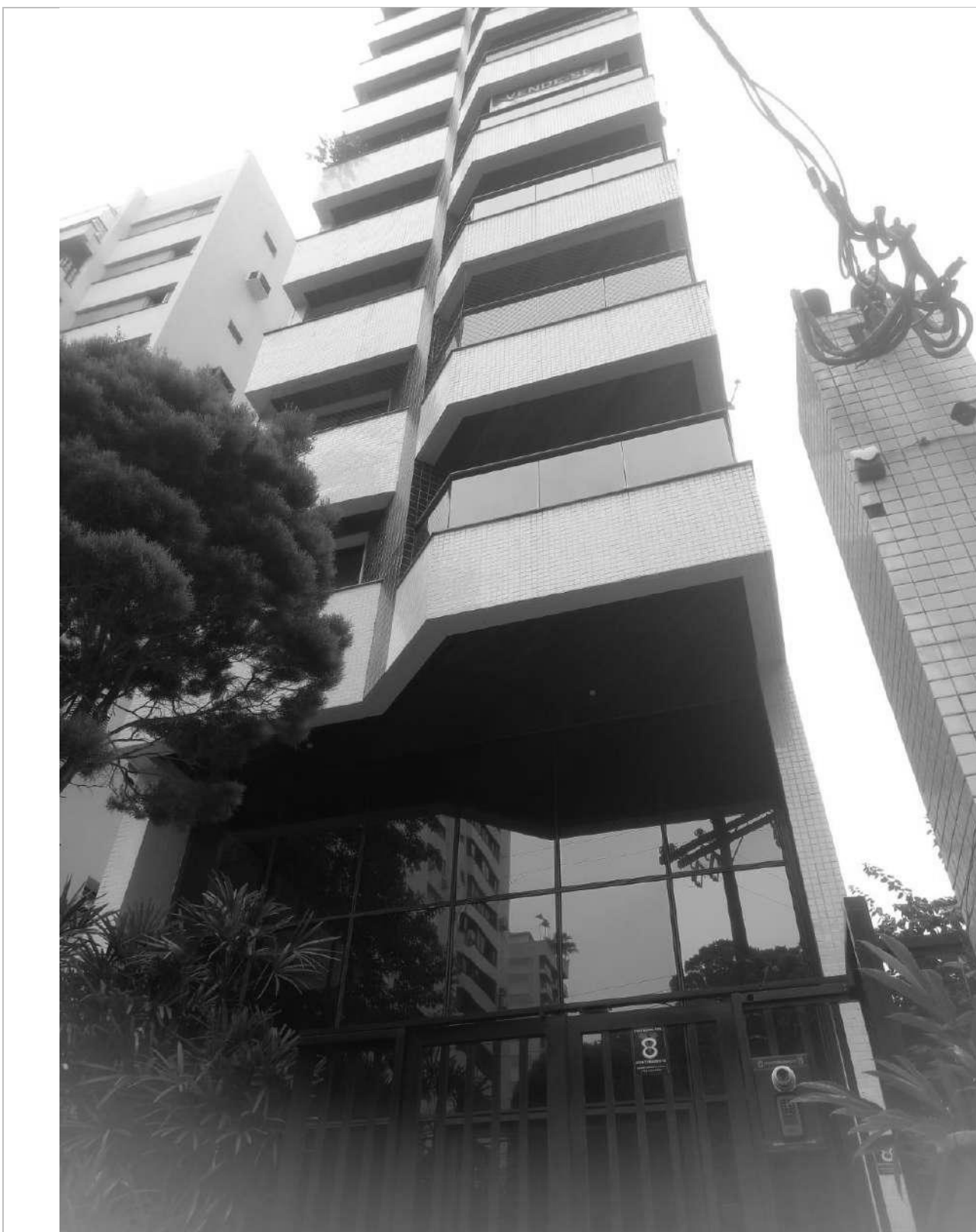
Outra parcial da fachada frontal evidenciando os acabamentos (fechamentos em vidro azul espelhado e alumínio pintado também em azul).
