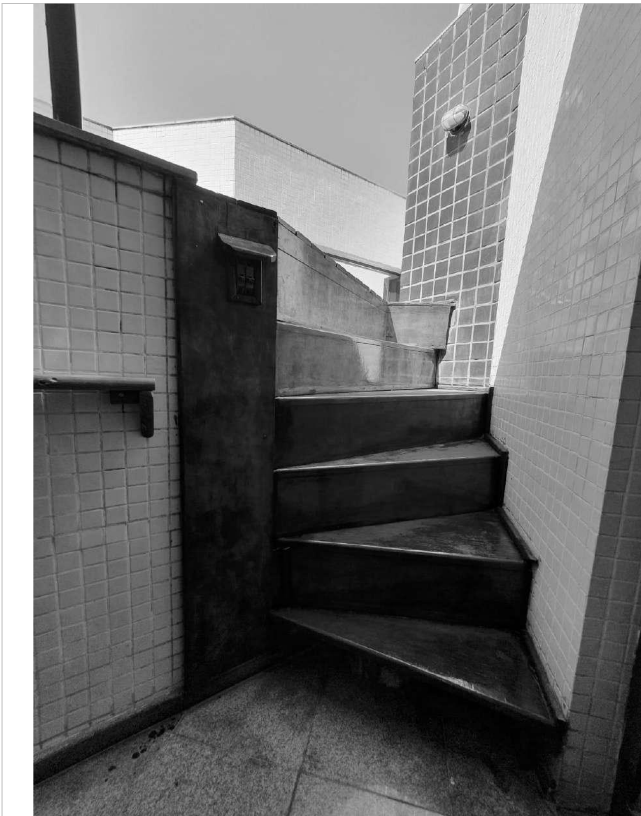
Escala de acesso ao "deck" da piscina.
