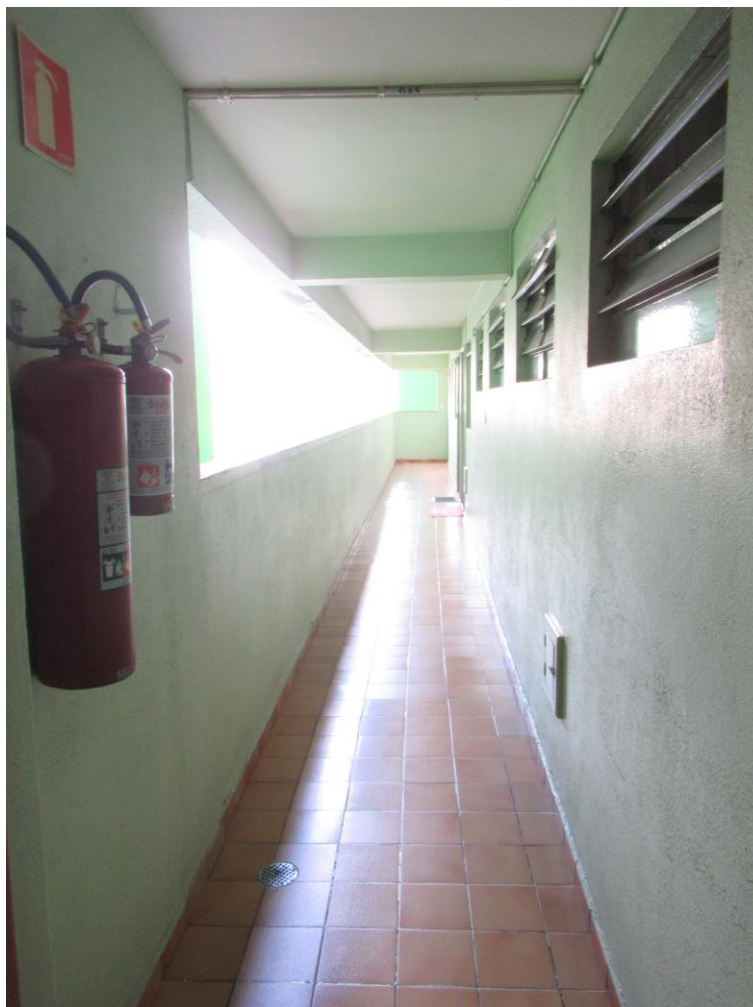
Foto nº. 12 – Vista do corredor no 4º pavimento tipo.
