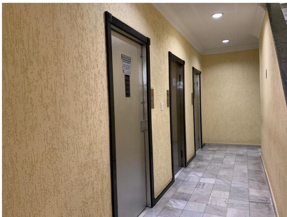
Foto nº. 9 – Vista em detalhe dos elevadores.
