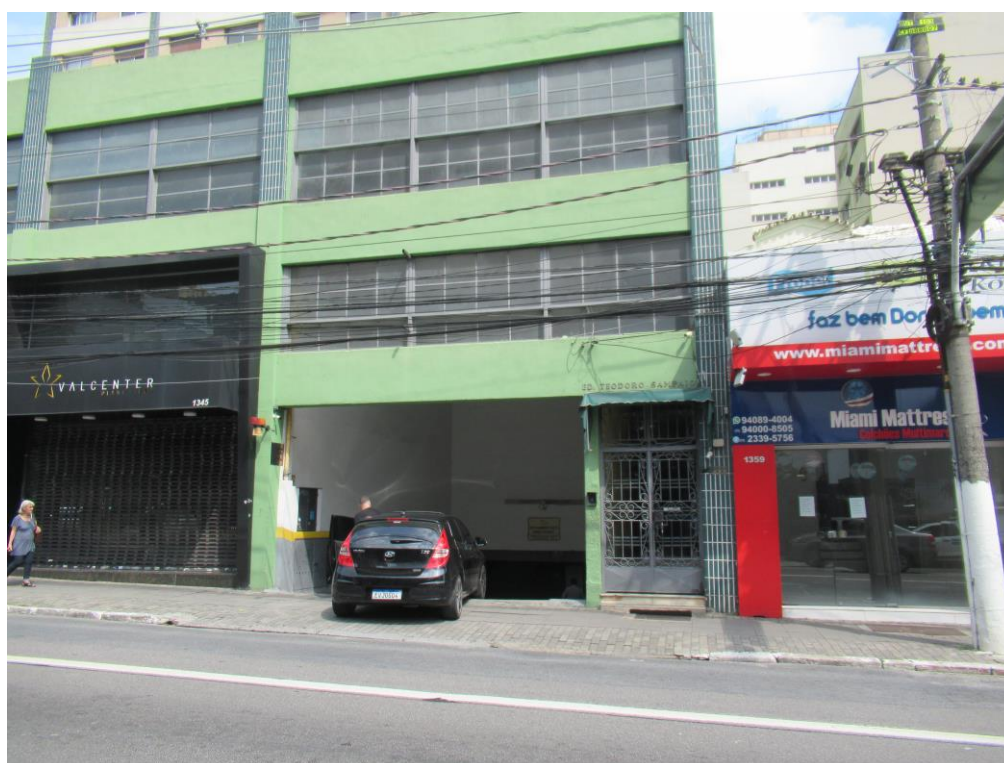
Foto nº. 5 – Vista das entradas do Condomínio Edifício Teodoro Sampaio.
