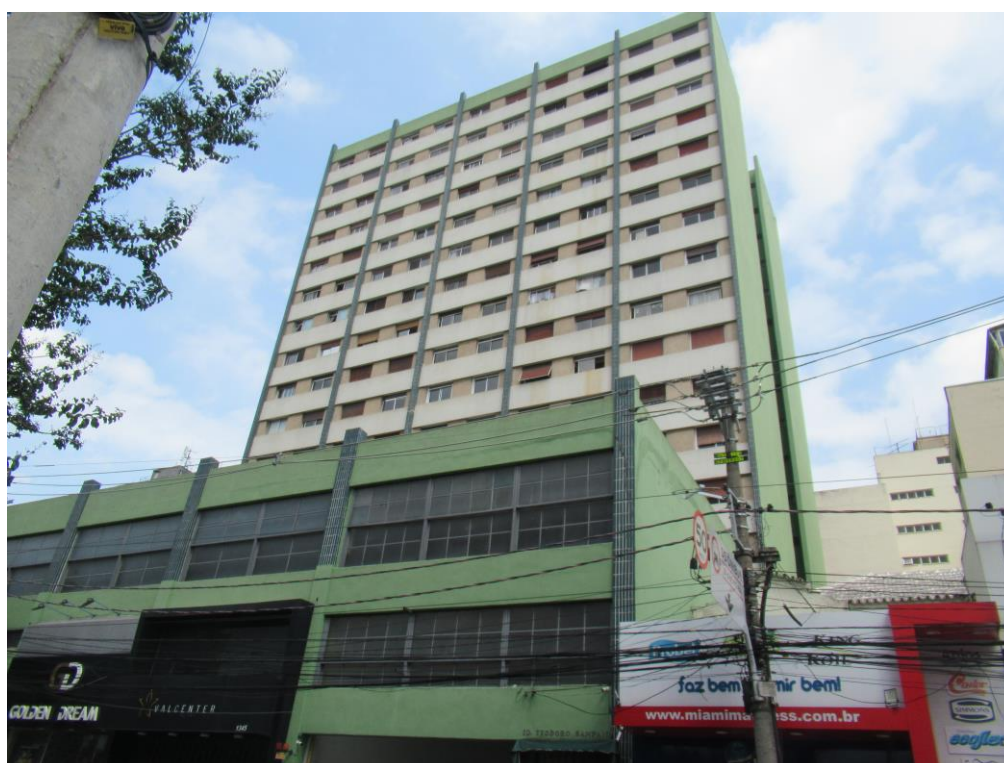
Foto nº. 3 – Vista da fachada frontal do Condomínio Edifício Teodoro Sampaio.
