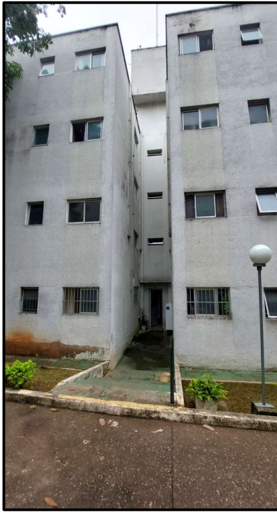
Foto 9: Apartamento 12 – acesso ao imóvel
