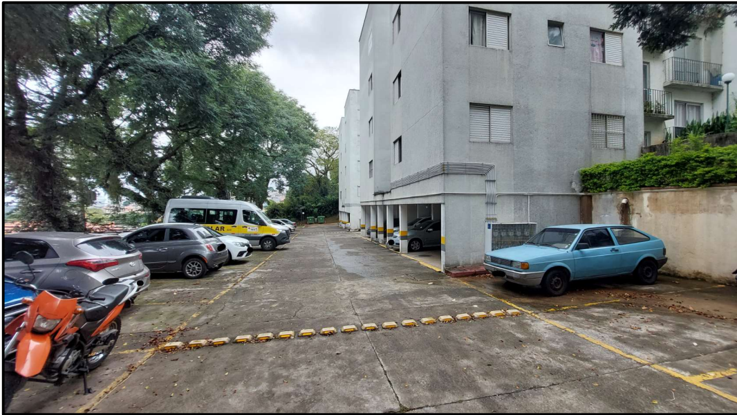
Foto 5: Pavimento Térreo – Garagem
