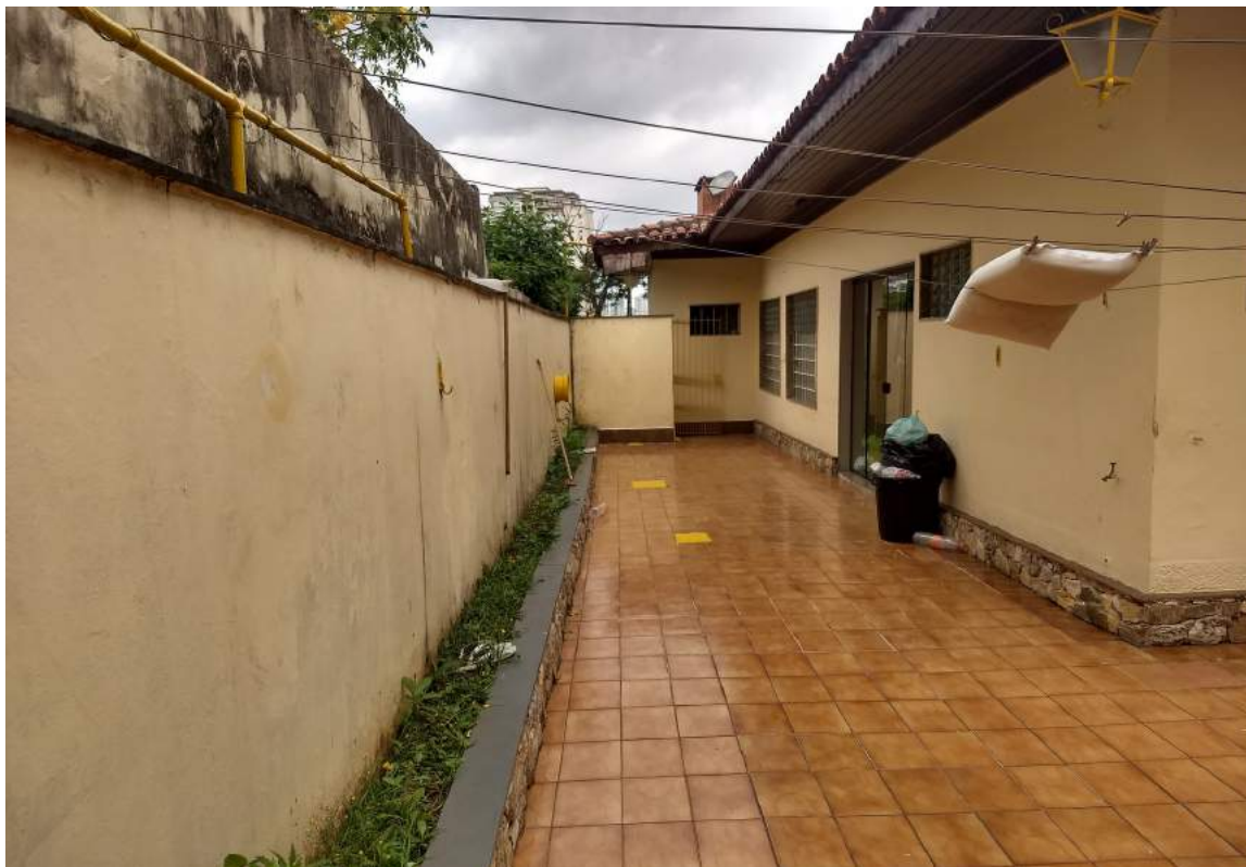
Passeio Direito - Acesso para a Lavanderia, Porta Principal e Quintal
