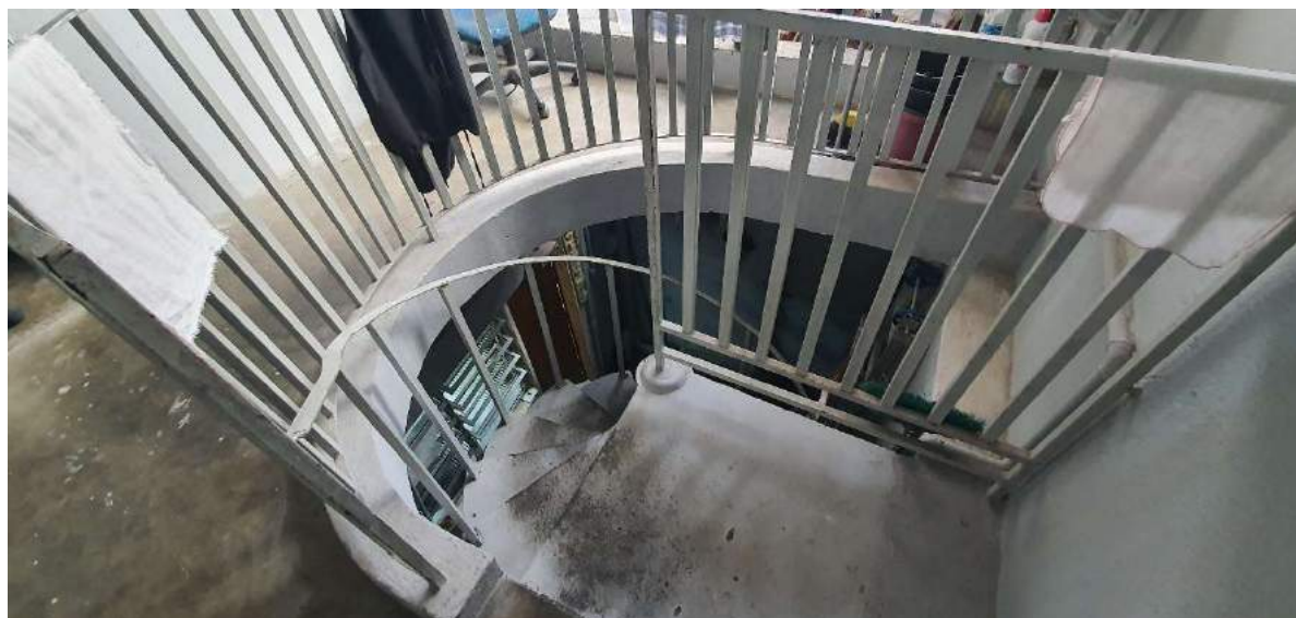
FOTO 85: ACESSO ESCADA, CHEGADA AO PISO SUPERIOR.
