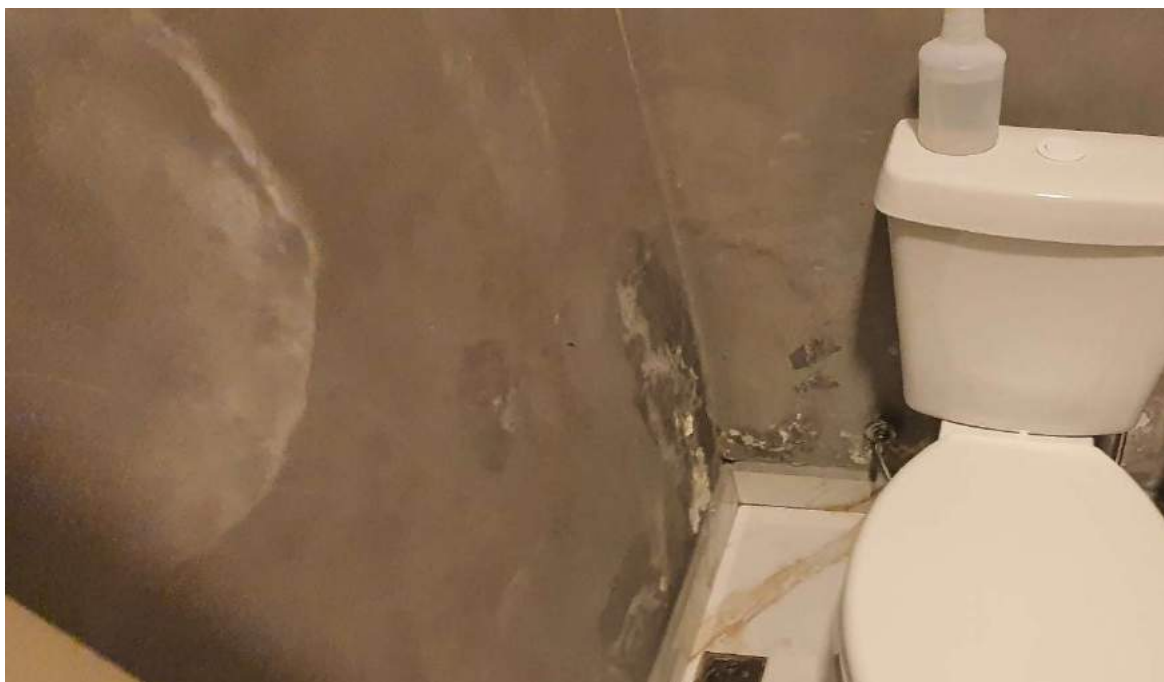
FOTO 65: BANHEIRO FEMININO, INFILTRAÇÃO NA PAREDE.
