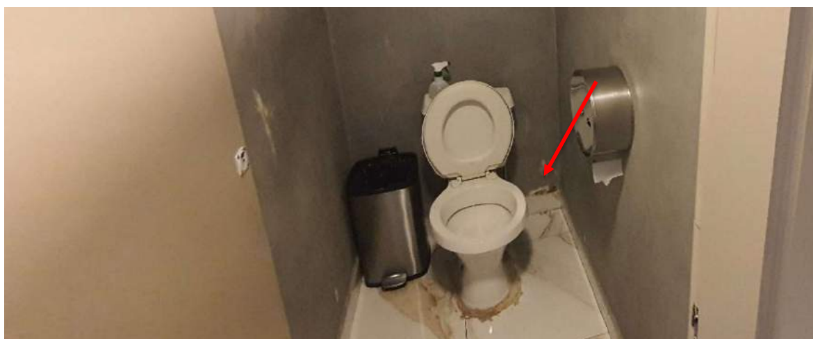
FOTO 71: BANHEIRO MASCULINO, CONTINUAÇÃO, VAZAMENTO À DIREITA NO SEGUNDO VASO.
