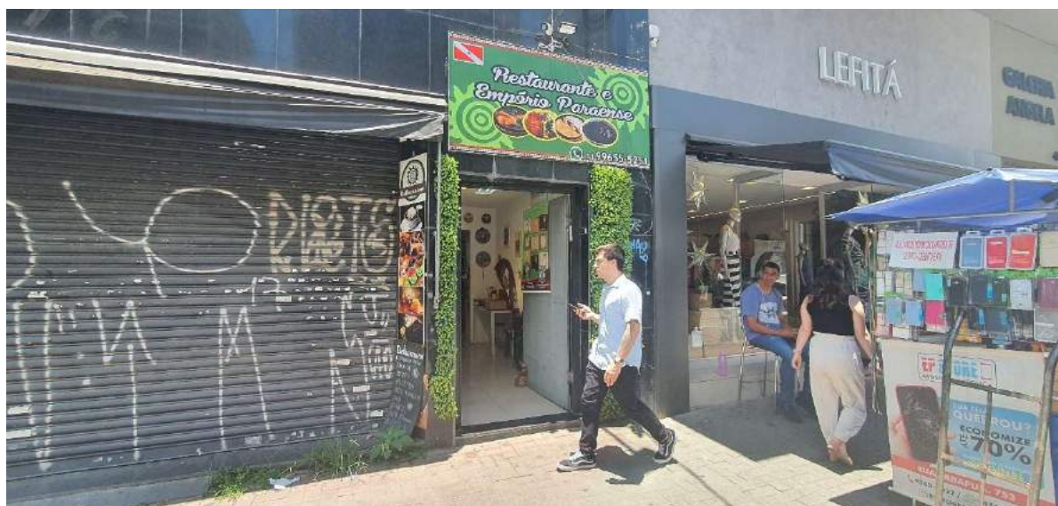
FOTO 05: VISTA DA ENTRADA À DIREITA DO IMÓVEL AVALIANDO, QUE DÁ ACESSO AO NÍVEL SUPERIOR, PELA FRENTE.
