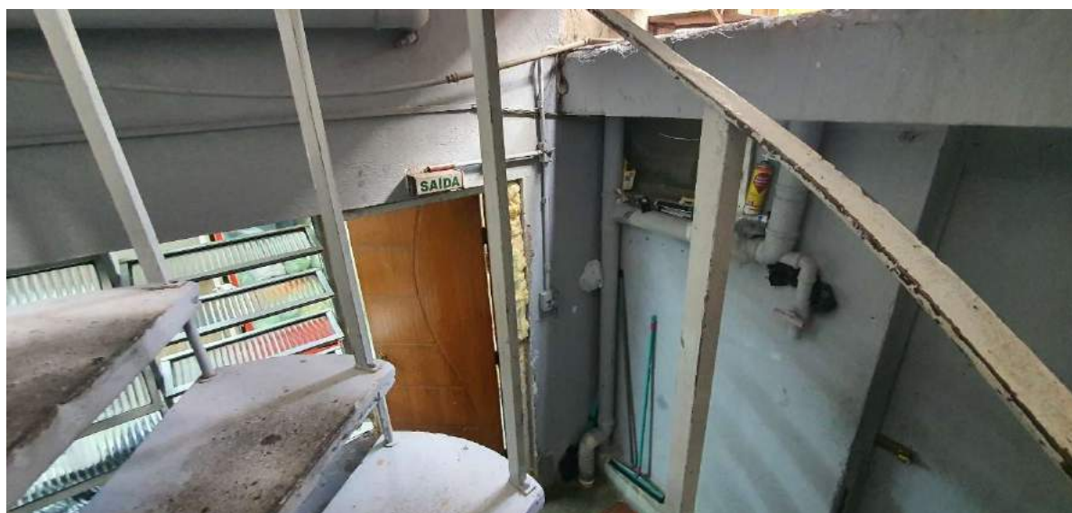
FOTO 84: ACESSO ESCADA, VISTA OPOSTA.
