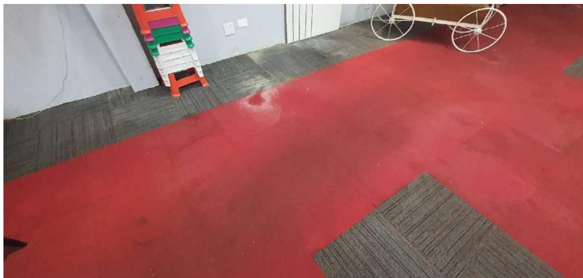
FOTO 25: SALÃO SUPERIOR, PISO COM MANCHAS DE INFILTRAÇÃO.
