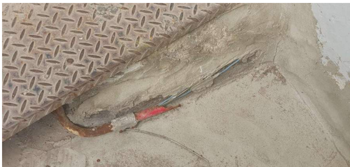
FOTO 99: ÁREA DESCOBERTA, NO INÍCIO DA ESCADA, TUBULAÇÃO E FIAÇÃO EXPOSTAS.
