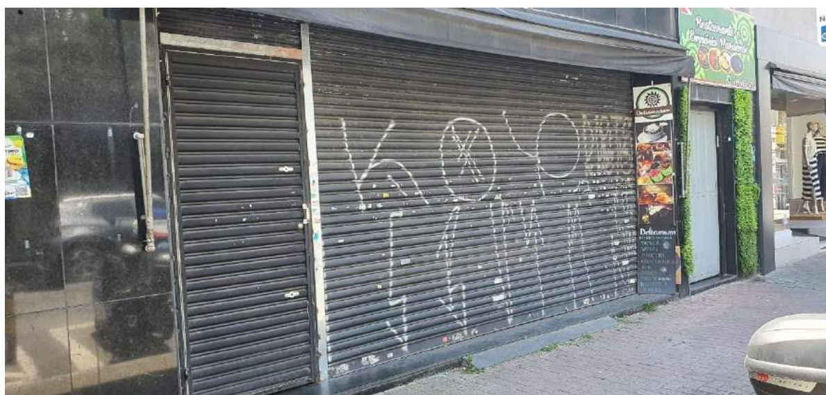
FIGURA 1: VISTA DA ENTRADA DO IMÓVEL AVALIANDO.
