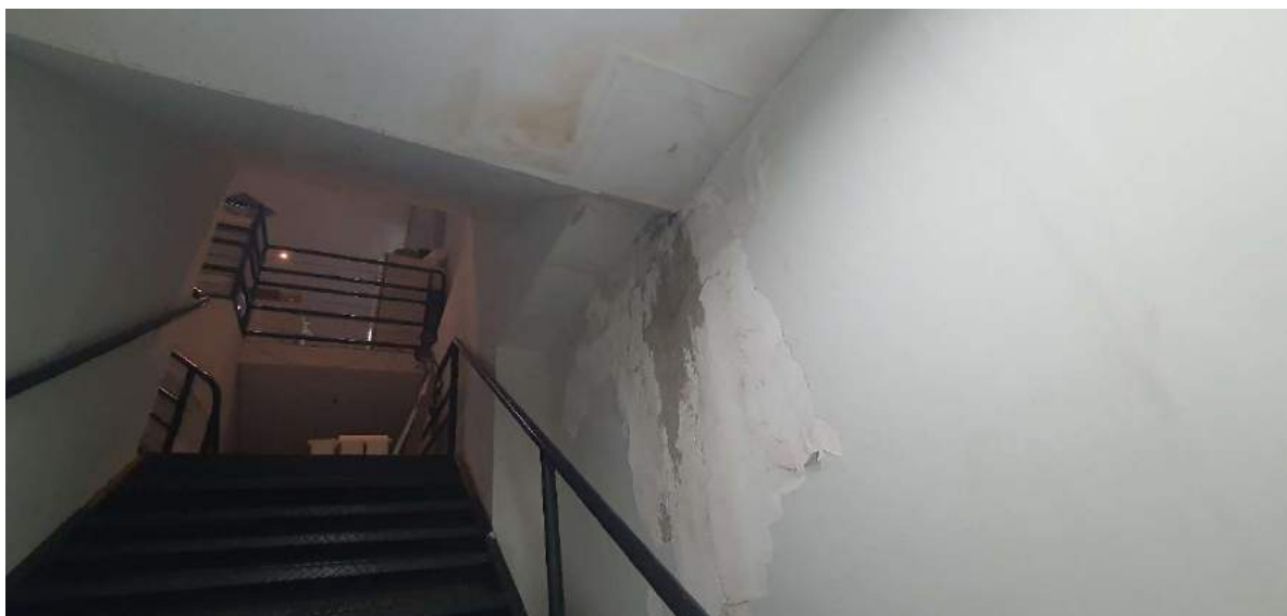
FOTO 12: PONTO DE INFILTRAÇÃO NA ESCADA DE ACESSO AO SALÃO SUPERIOR.
