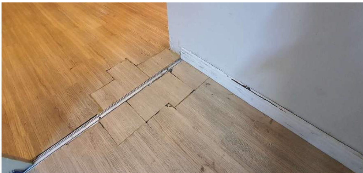
FOTO 76: PASSAGEM, PISO COM REPAROS E RODAPÉ DANIFICADO.
