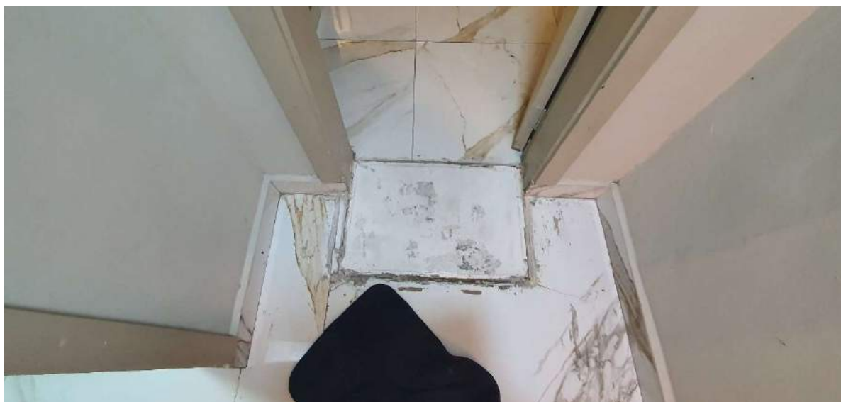
FOTO 72: VISTA DA ENTRADA DO BANHEIRO MASCULINO, ACABAMENTO DA TAMPA DA CAIXA DE ESGOTO.
