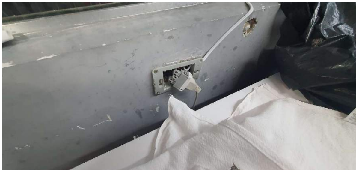
FOTO 81: COZINHA, TOMADA ABAIXO DA JANELA COM FIAÇÃO EXPOSTA E SEM ACABAMENTO.
