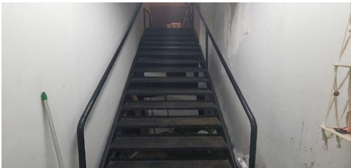
FOTO 11: VISTA DO INÍCIO DA ESCADA PARA O SALÃO SUPERIOR.
