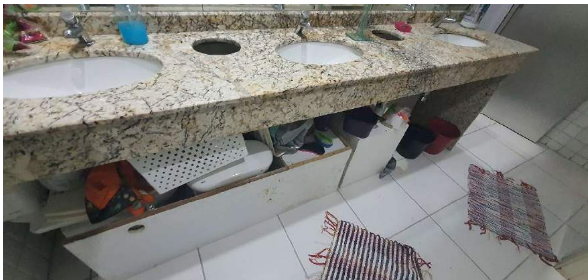
FOTO 35: BANHEIRO ESQUERDO, CONTINUAÇÃO.
