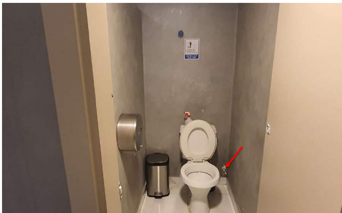
FOTO 70: BANHEIRO MASCULINO, CONTINUAÇÃO, PONTO DE INFILTRAÇÃO NO LADO DIREITO DO VASO SANITÁRIO.
