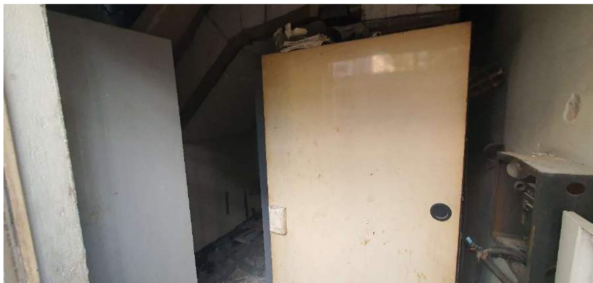
FOTO 102: VISTA DA ENTRADA DA SALA DO AR-CONDICIONADO.
