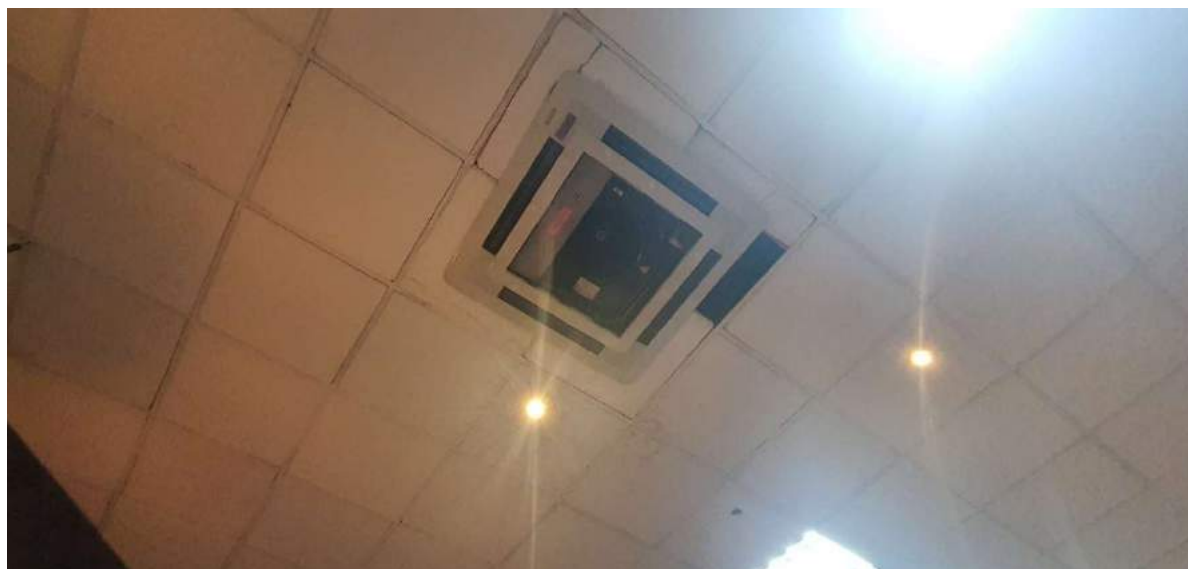
FOTO 20: SALÃO SUPERIOR, AR-CONDICIONADO PARCIALMENTE DESMONTADO.
