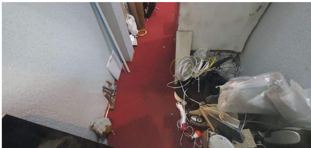
FOTO 31: ACESSO AO BANHEIRO DIREITO, VISTA OPOSTA.
