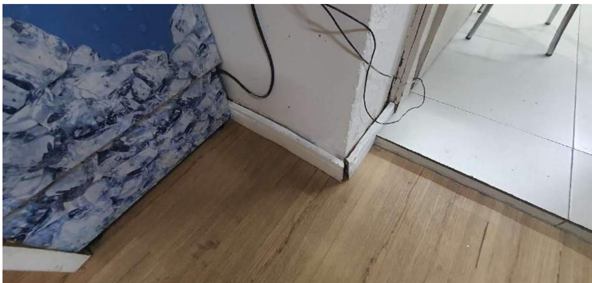
FOTO 75: PASSAGEM, RODAPÉ DESTACADO E FIAÇÃO EXPOSTA.
