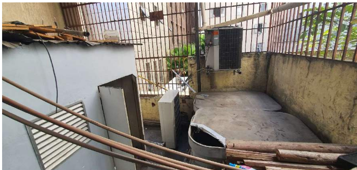
FOTO 96: VISTA DA ÁREA DESCOBERTA.
