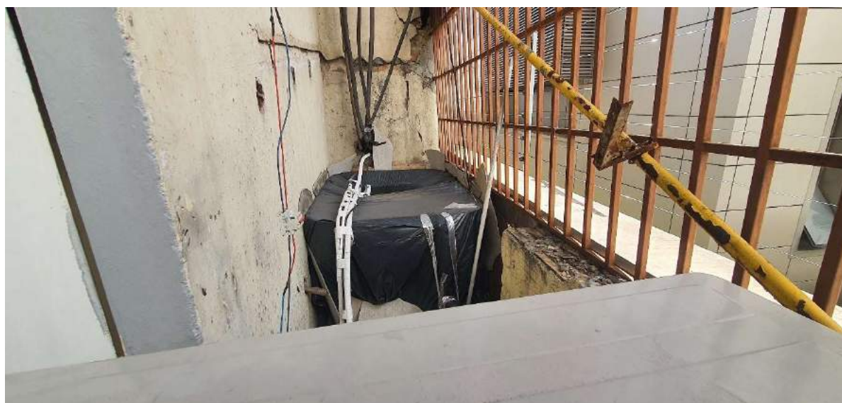
FOTO 97: ÁREA DESCOBERTA, CONTINUAÇÃO.
