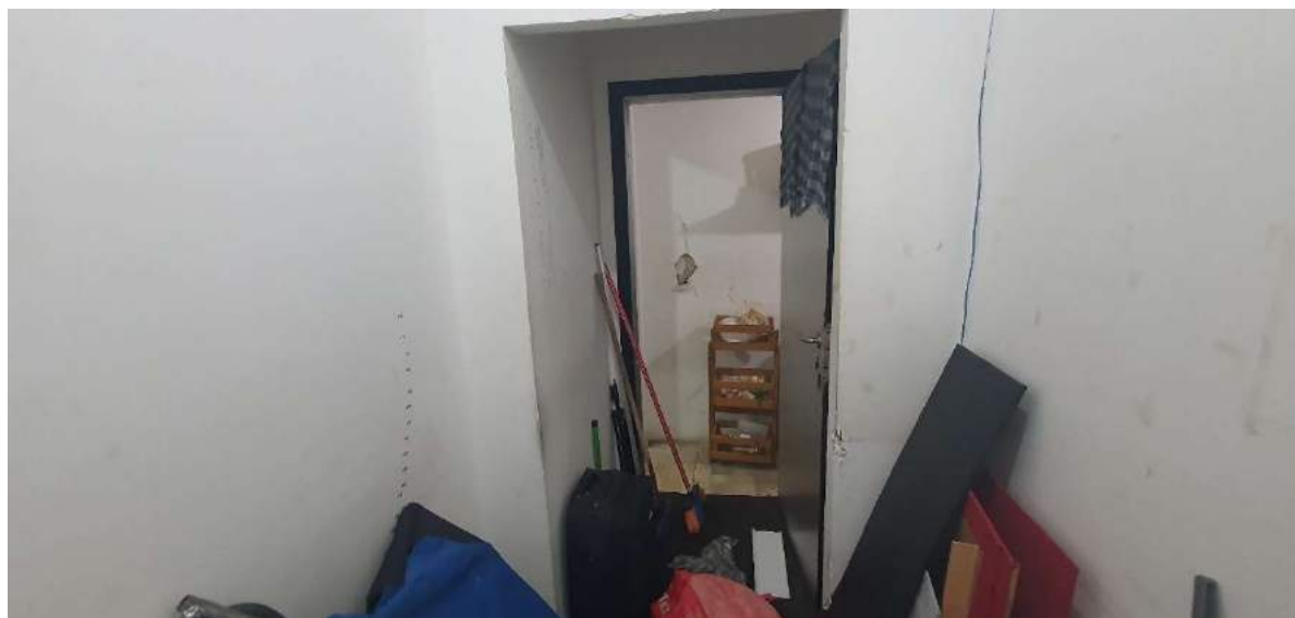
FOTO 40: DEPÓSITO 4, VISTA OPOSTA.
