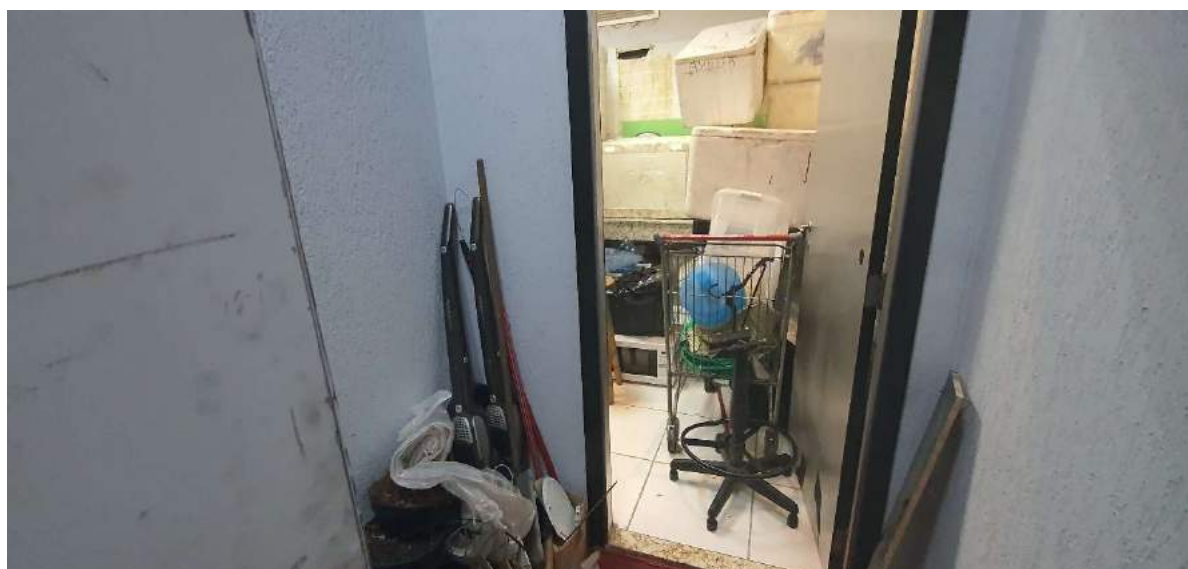
FOTO 26: VISTA DO ACESSO AO BANHEIRO DIREITO.
