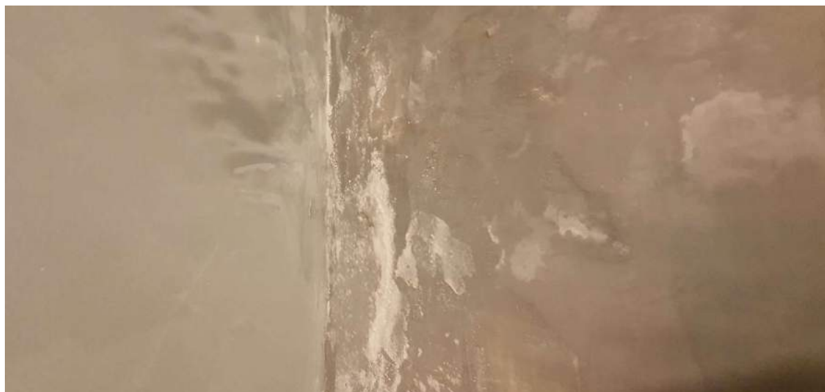
FOTO 66: BANHEIRO FEMININO, INFILTRAÇÃO NA PAREDE OPOSTA À PORTA.
