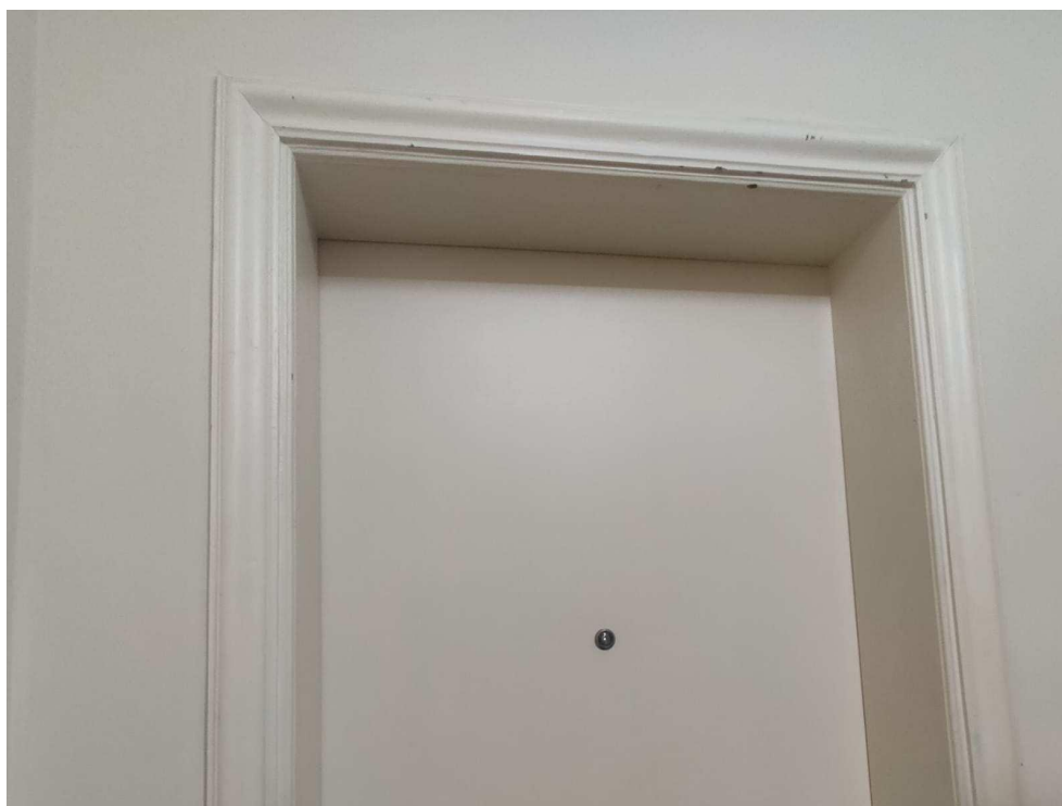
Figura 5 – Porta de acesso da unidade 51
