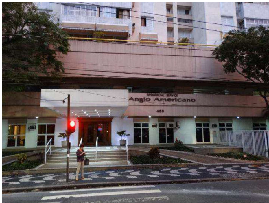
FOTO N° 2 - Vista da entrada do condomínio.
