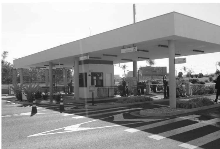
02. Vista da portaria do condomínio onde está o imóvel avaliado
