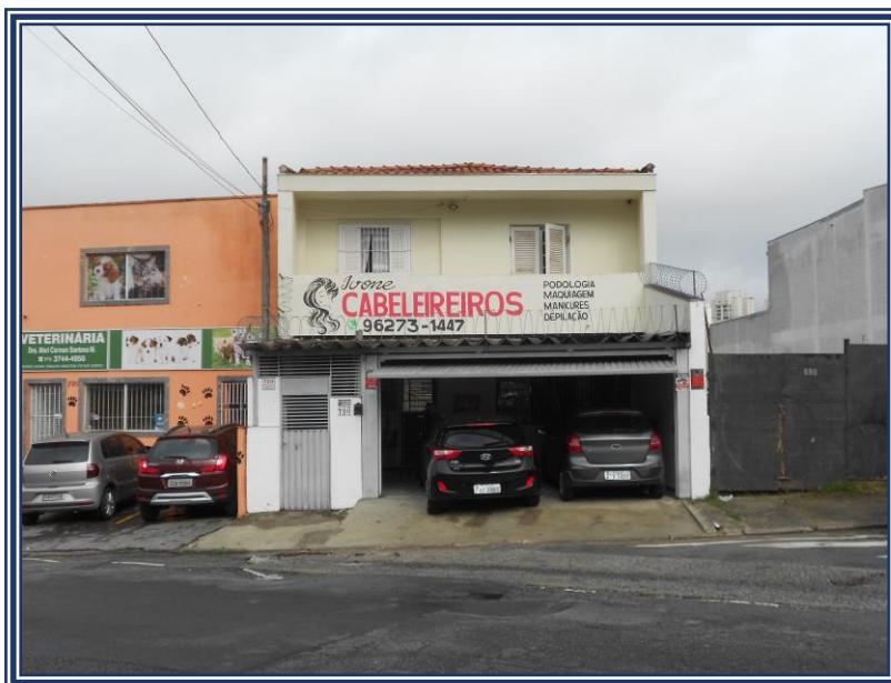
Vista da frente do imóvel avaliando.
