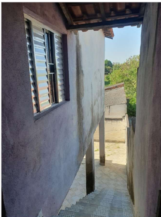
Foto 12: Escada de acesso ao porão/quintal.
