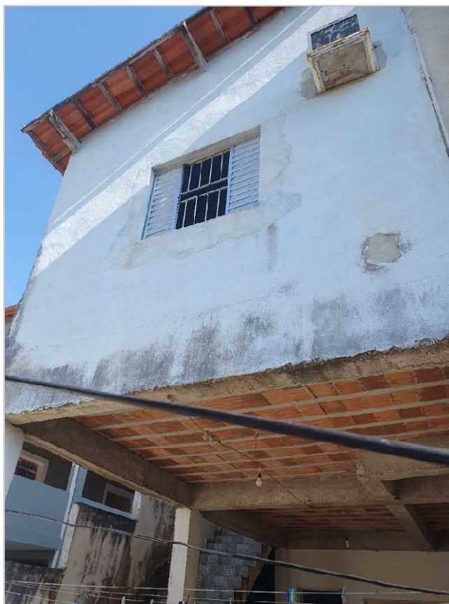
Foto 14: Quarto dos fundos.
