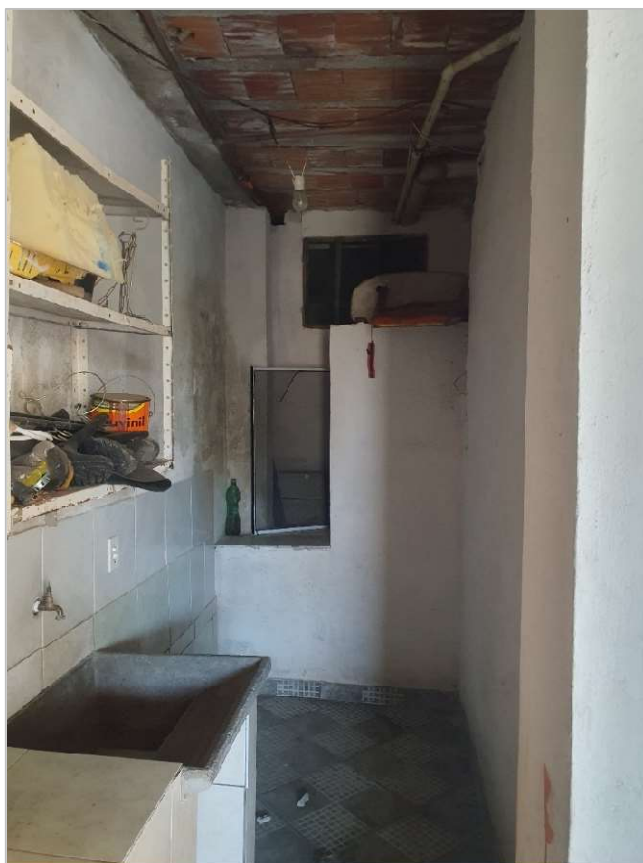
Foto 18: Lavanderia do porão.
