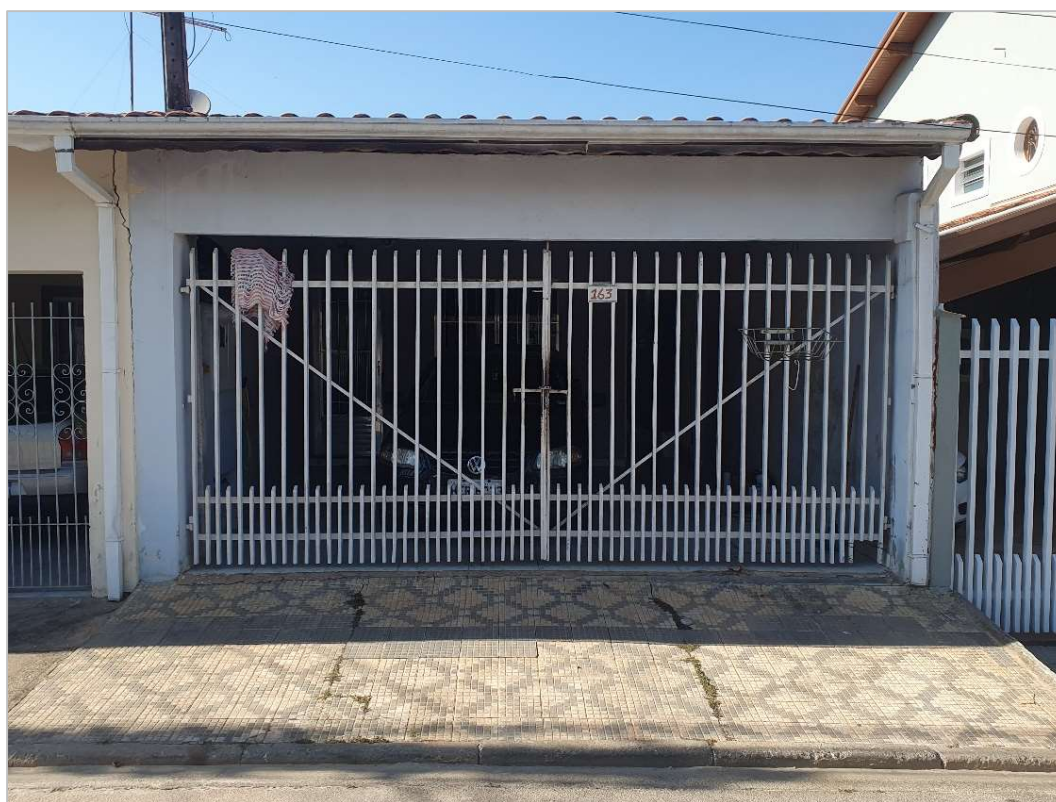
Foto 1: Fachada do imóvel avaliando. Fonte: A autora.
