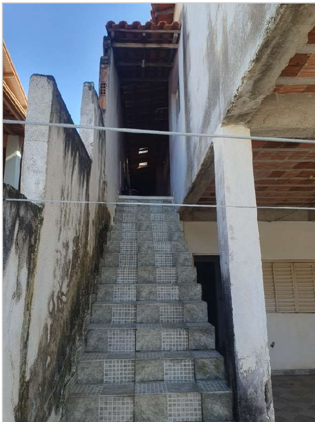
Foto 13: Escada de acesso ao porão/quintal vista pelo quintal.
