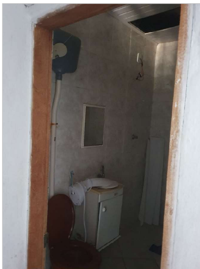
Foto 21: Banheiro do porão.
