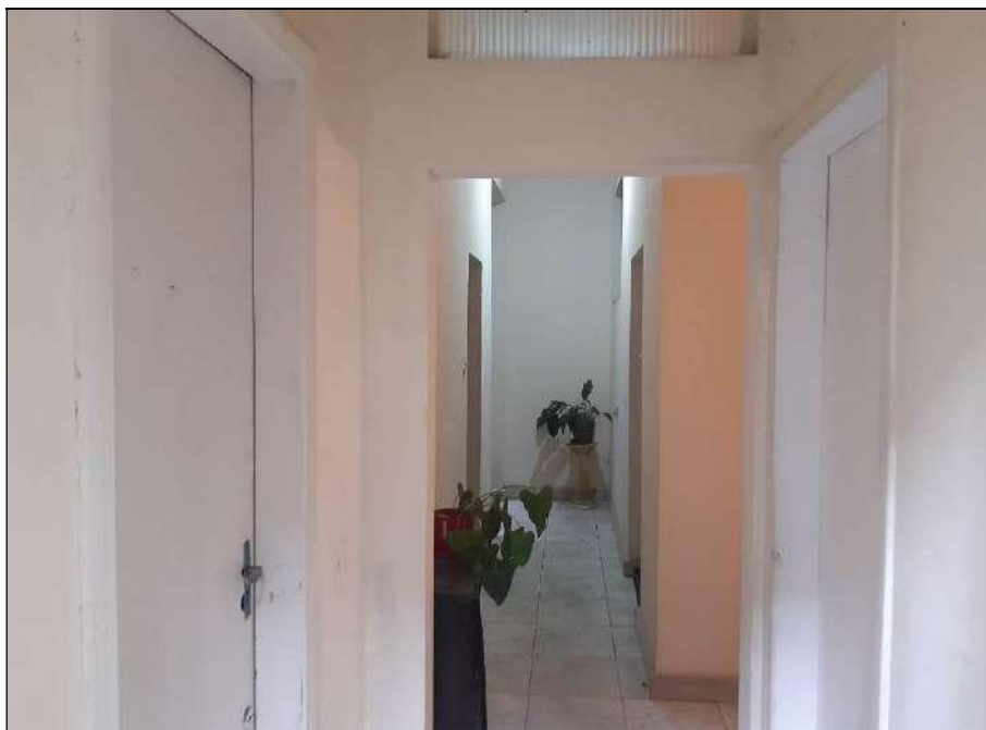
Vista do corredor de acesso as residências 02 a 06.
