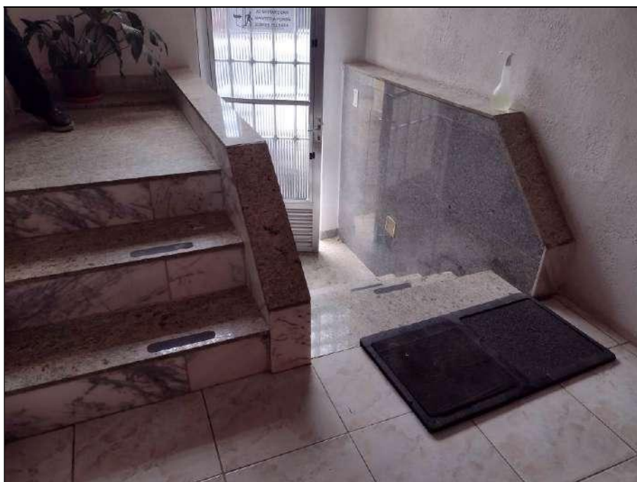
Vista da escada de acesso ao superior.
