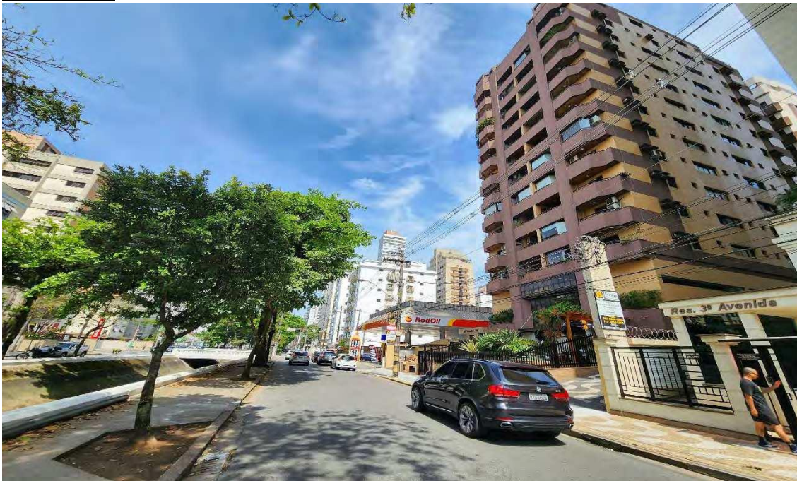
VISTA DO ENTORNO DO CONDOMÍNIO EDIFÍCIO PAPEETE.
