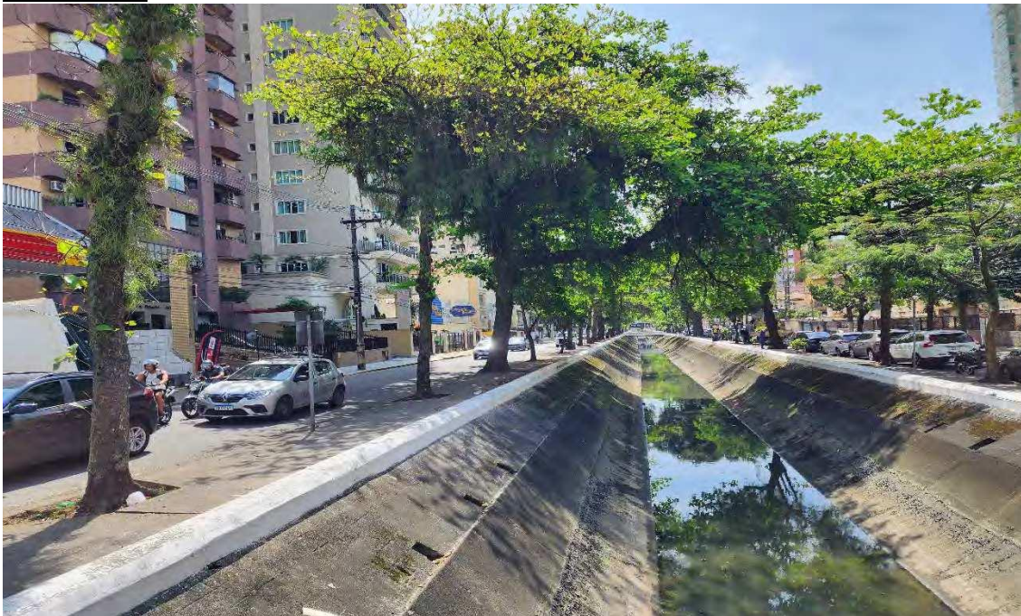
VISTA DO ENTORNO DO CONDOMÍNIO EDIFÍCIO PAPEETE.
