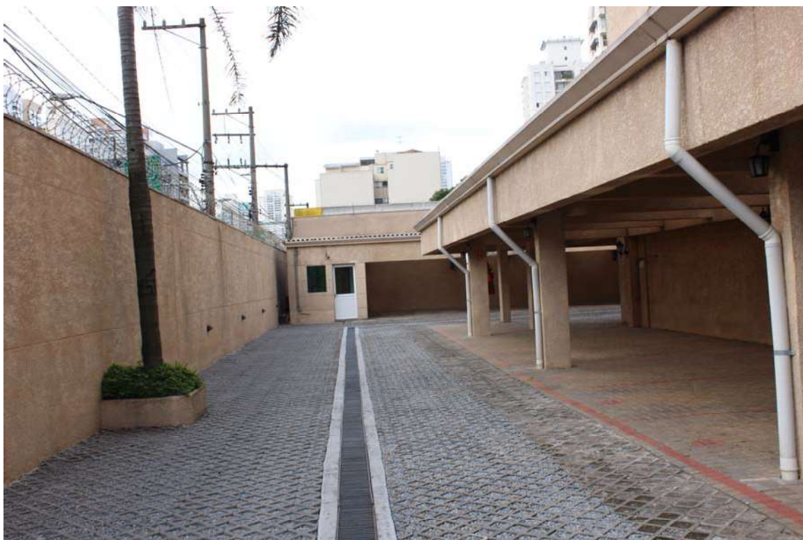
Fotografia 05 – Aspecto da área do Condomínio Edifício Villadry onde se situam as vagas externas de garagem.
