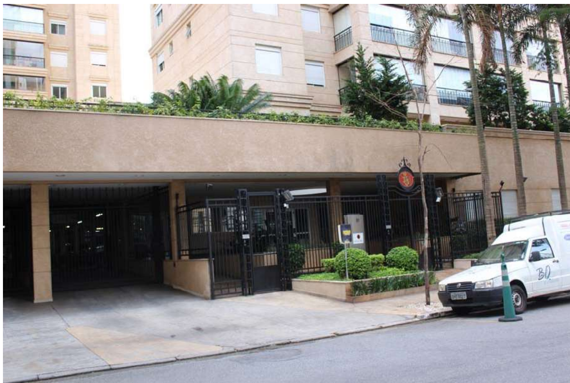
Fotografia 02 – Aspecto da entrada do Condomínio Edifício Villadry na Rua Princesa Isabel, nº 89.
